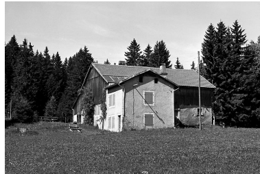
Ferme située au lieudit La Coupe. Phot. Dominique Dominguez IVR43_19792500886X
