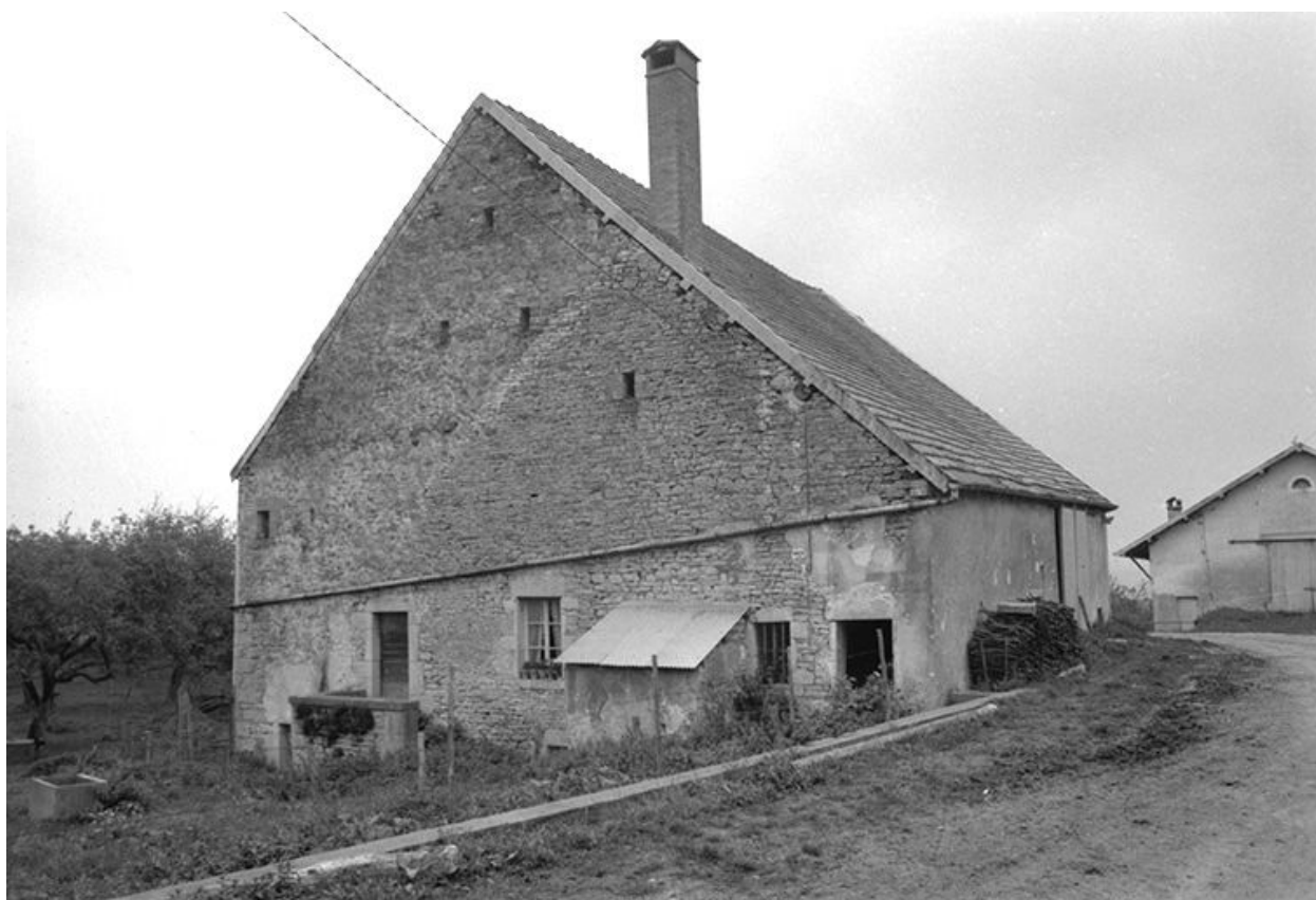
Façade antérieure et face latérale droite.
