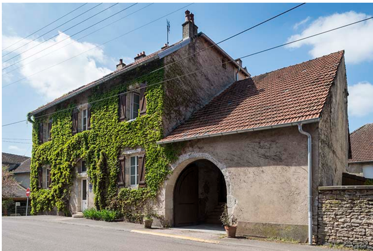
La grange, adossée au mur pignon Nord.
