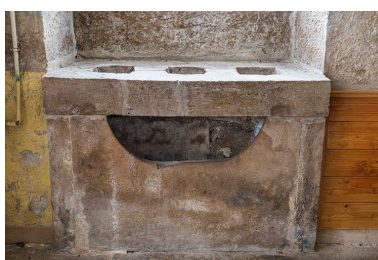
Le potager, placé sous la fenêtre. Phot. Jérôme Mongreville IVR43_20177000878NUC4A
