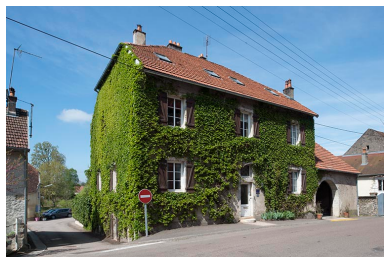
Vue d'ensemble. Phot. Jérôme Mongreville IVR43_20177000702NUC4A
