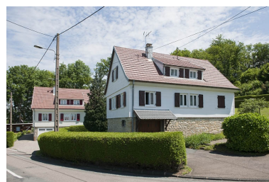
Maisons individuelles rue Raoul Delattre. Phot. Jérôme Mongreville IVR43_20122501262NUC4A
