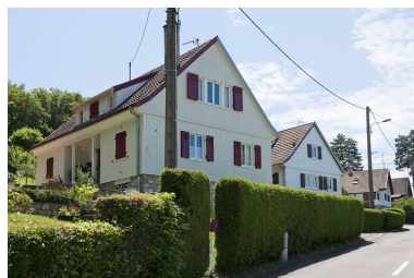
Pignons ouest des maisons rue Raoul Delattre. Phot. Jérôme Mongreville IVR43_20122501263NUC4A
