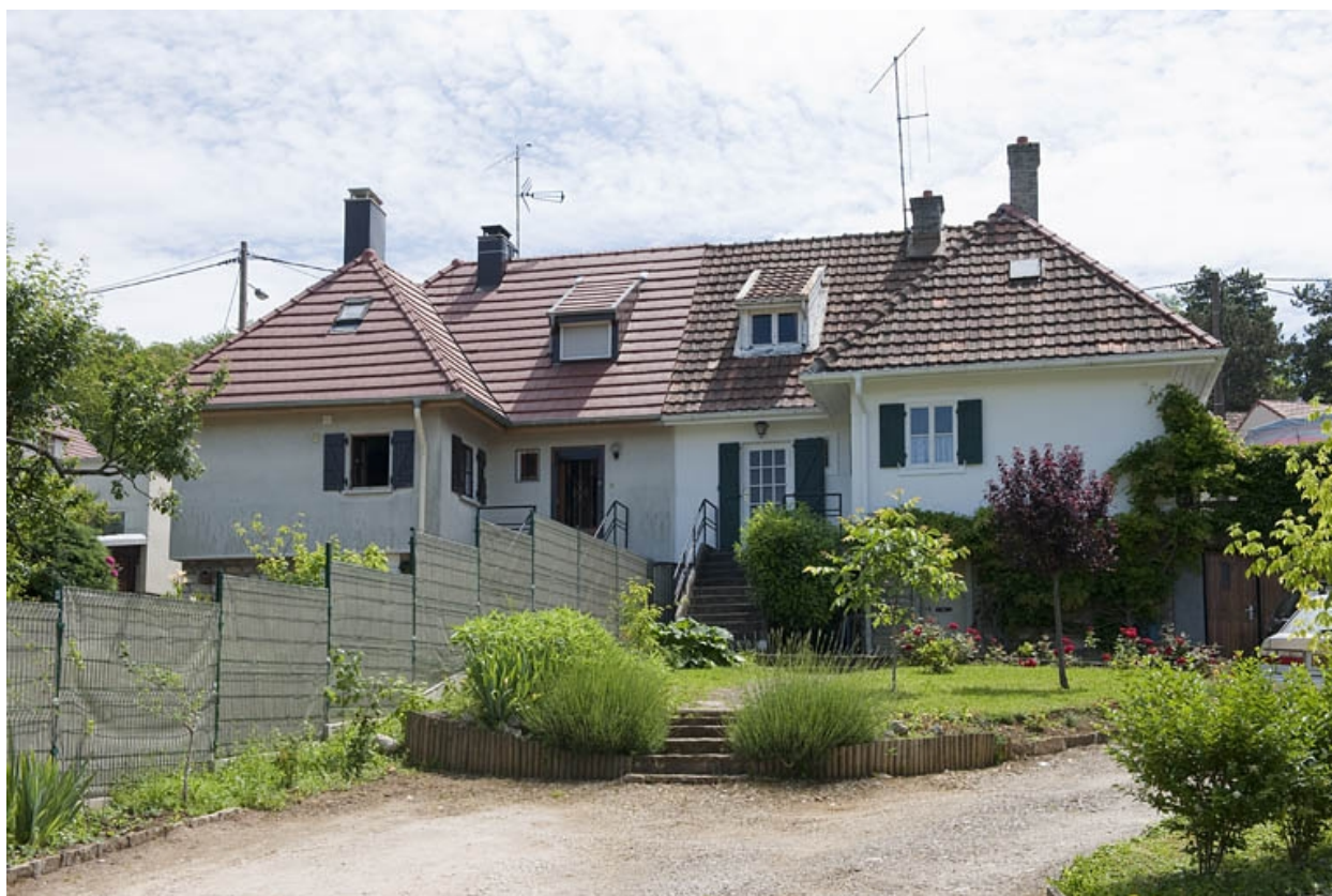
Maisons jumelles rue Raoul Delattre. Façades ouest.
