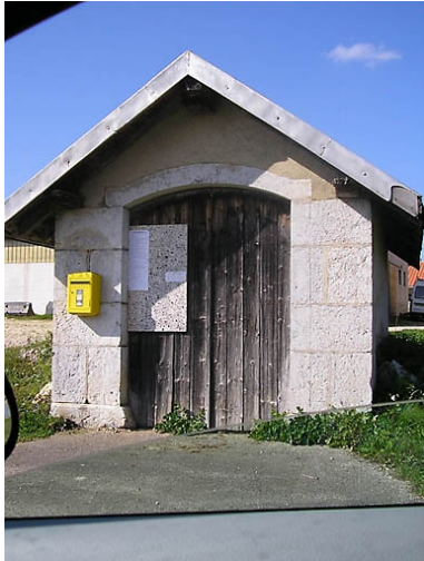
Vue de la façade antérieure. Phot. Marie-Pierre Reynet IVR43_20083900100NUC1A
