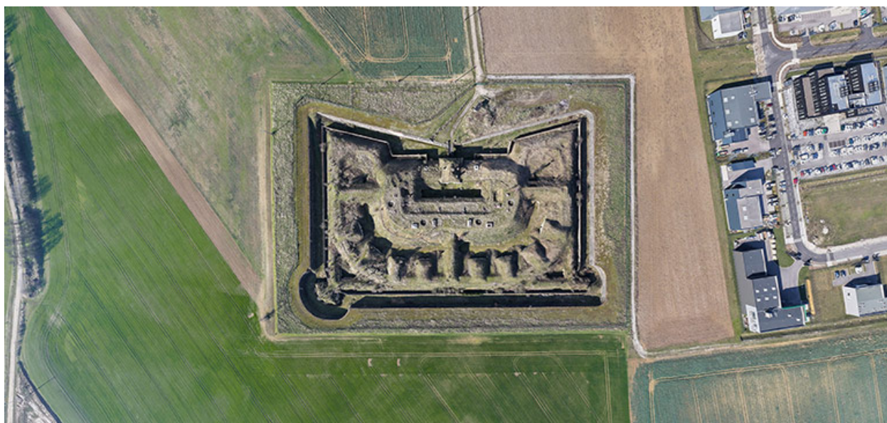
Le fort, vue d'ensemble. (vue aérienne).
