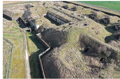
Le fossé à la gorge du fort et son escarpe de type Carnot. (vue aérienne). Phot. Nicolas Douriaux IVR26_20262100381NUC4A
