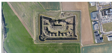
Le fort, vue d'ensemble. (vue aérienne).
