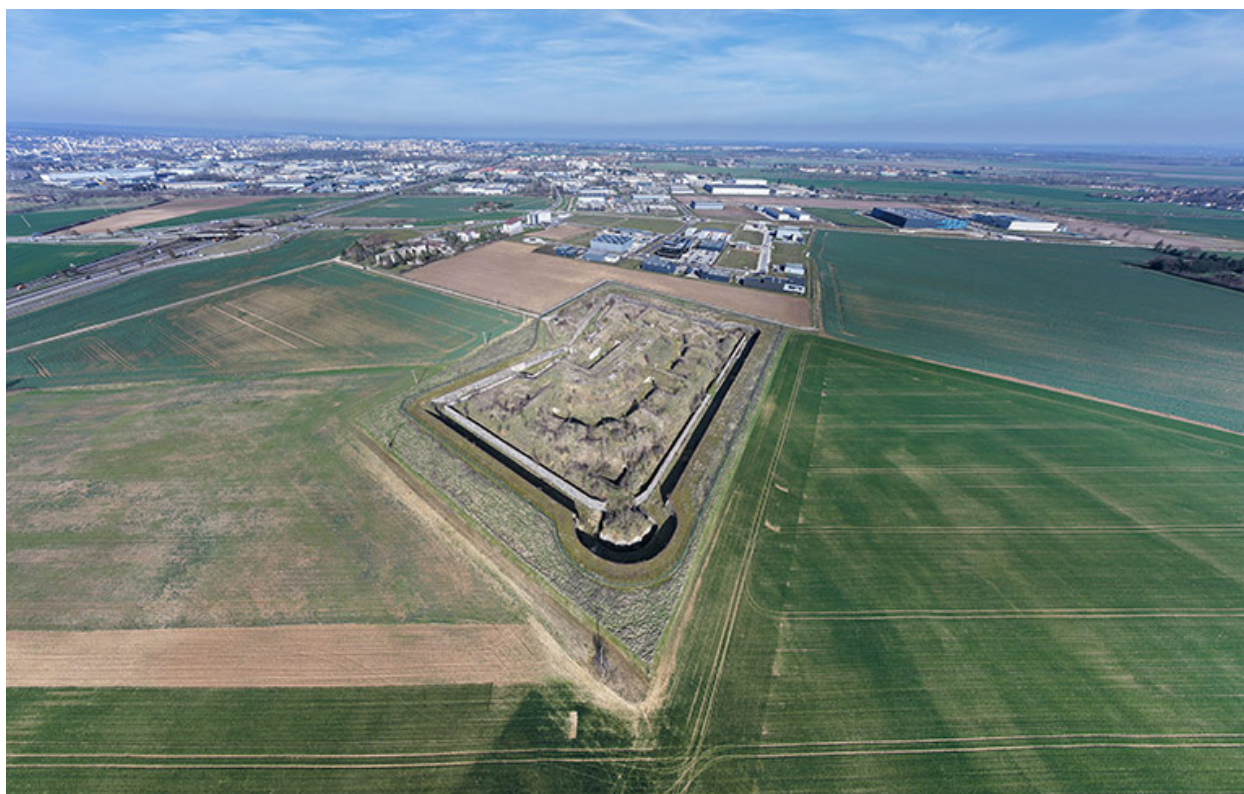
Vue sud-est. (vue aérienne).
