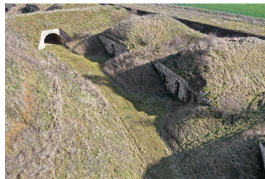
La rue des Remparts. (vue aérienne). Phot. Nicolas Douriaux IVR26_20262100371NUC4A
