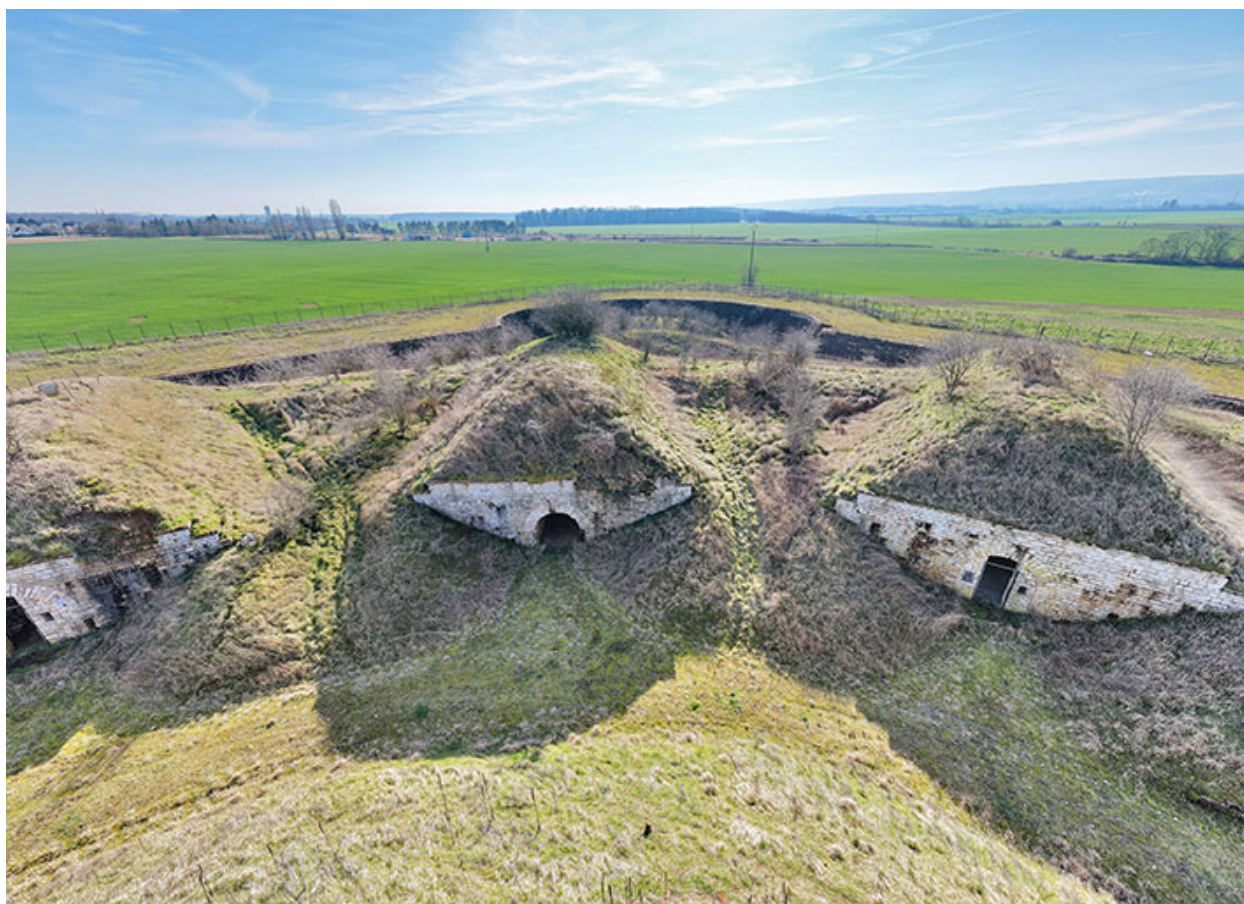
Les traverses-abris et plateformes de tir au front d'attaque. (vue aérienne).
