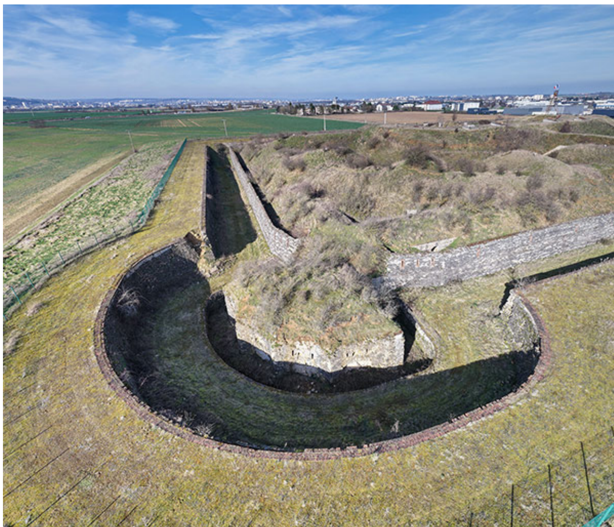
La double caponnière, au saillant 3. (vue aérienne).
