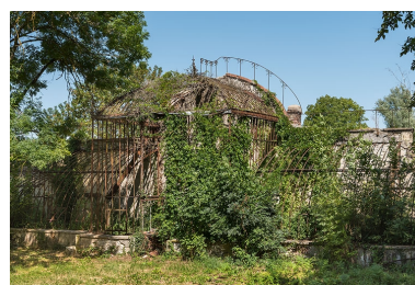
Pavillon central, vue de trois-quarts. Phot. Pierre-Marie Barbe-Richaud IVR26_20205800540NUC4A
