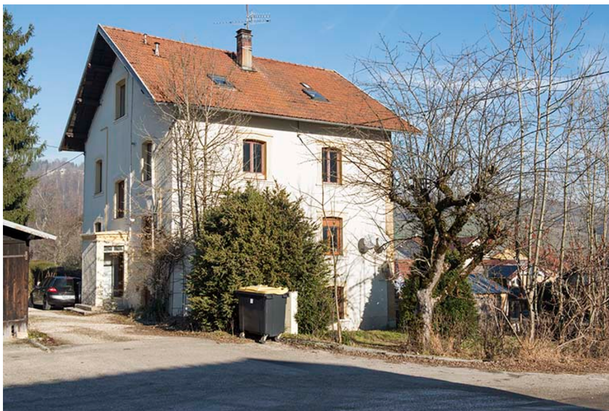
Façades postérieure et latérale gauche.
