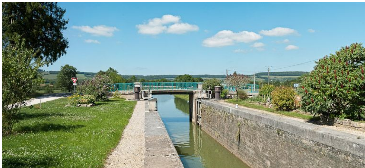
Vue du pont depuis l'amont.
