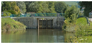
Vue du pont depuis l'aval. Phot. Pierre-Marie Barbe-Richaud IVR26_20112103696NUC4AQ
