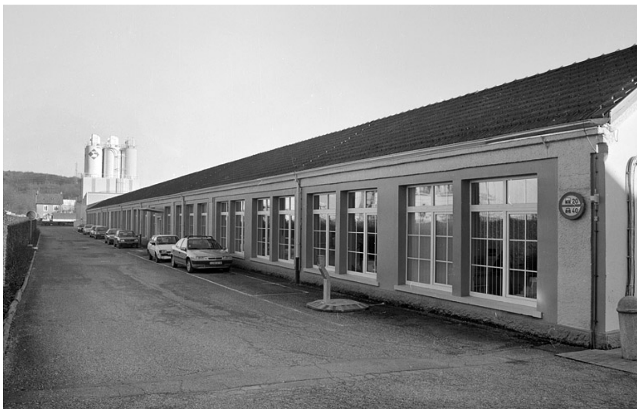
Façade nord de l'atelier de fabrication.
