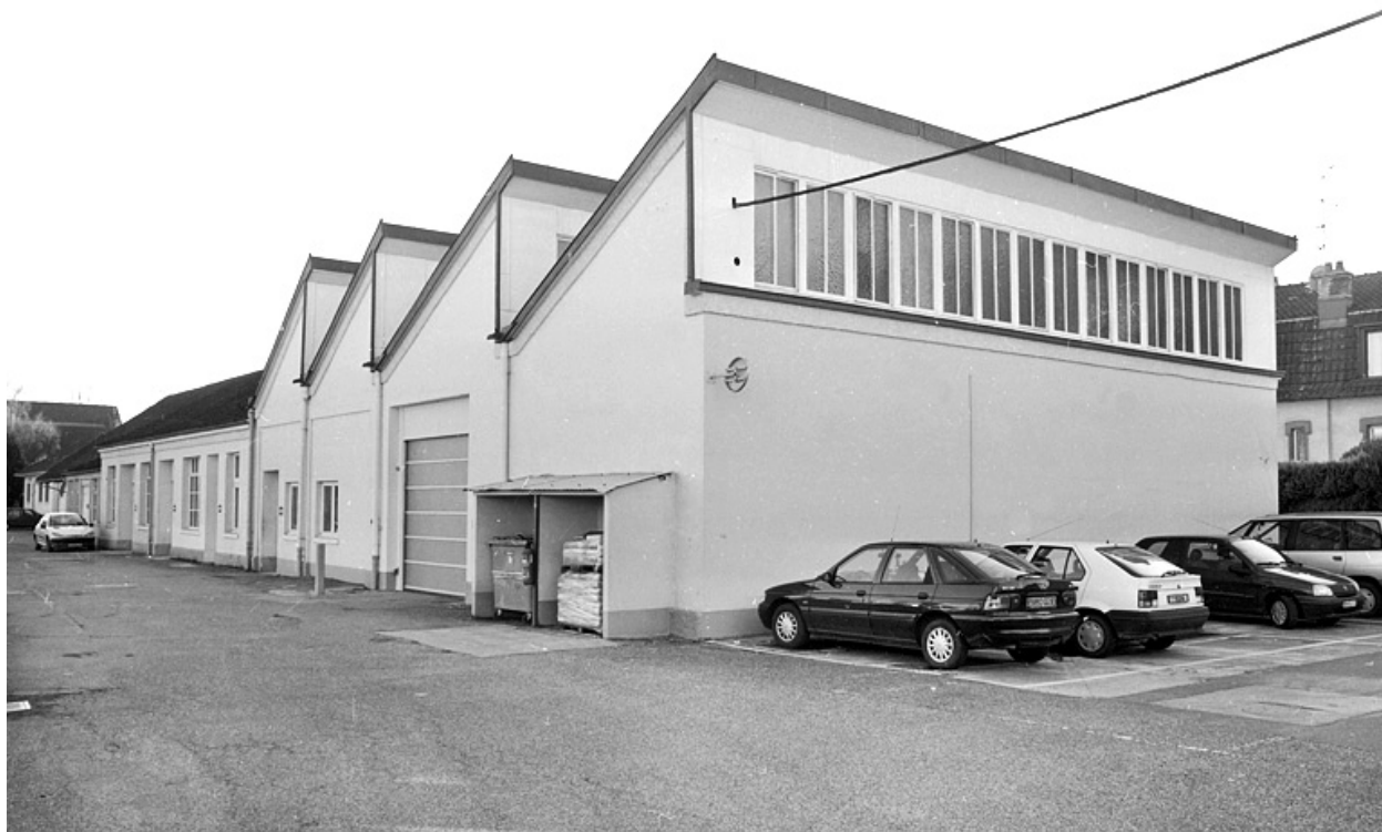
Atelier de réparation et magasin industriel.
