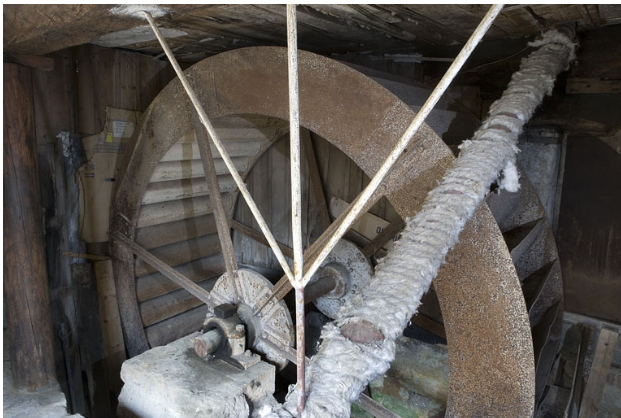
Roue hydraulique verticale, depuis l'amont.
