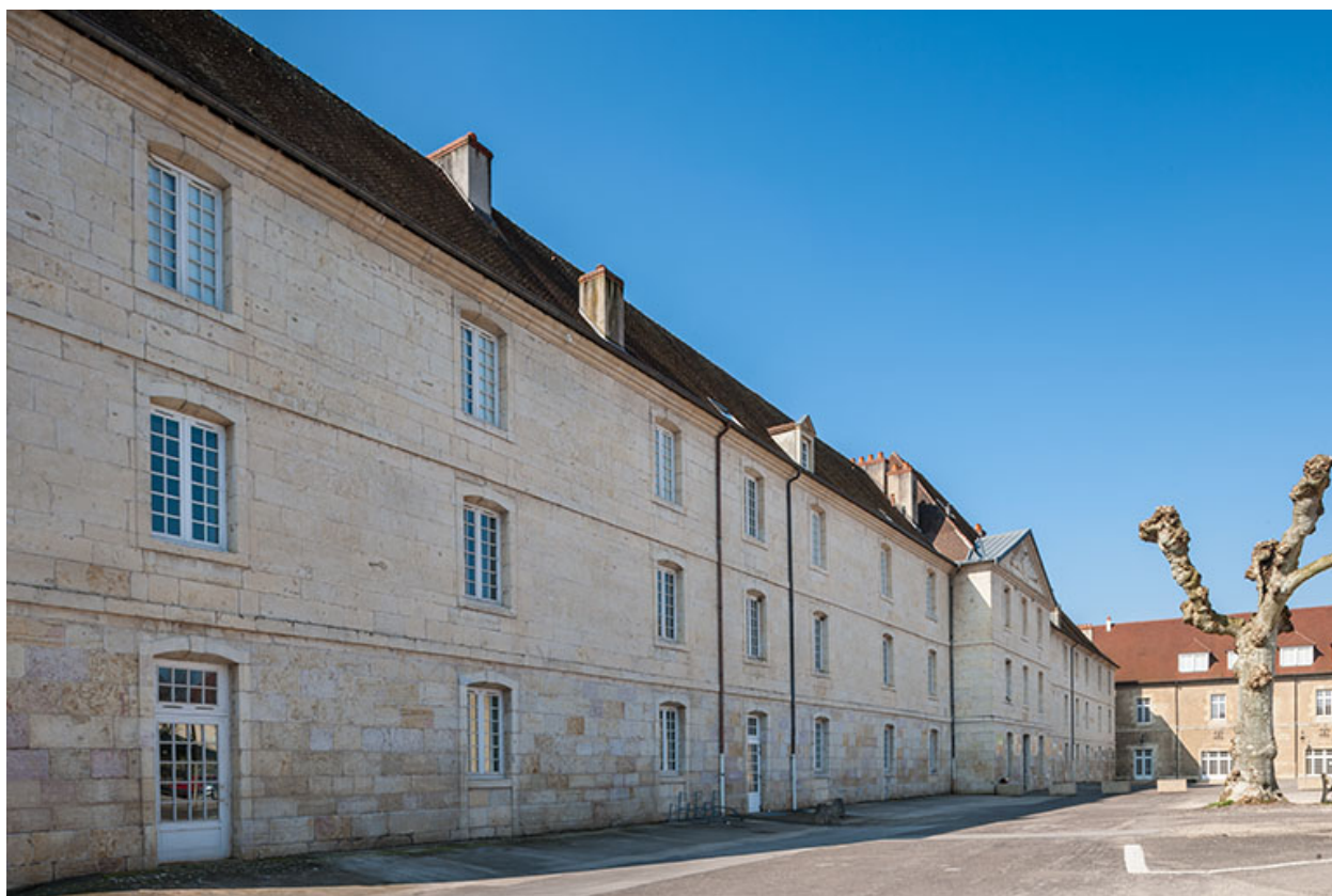
Externat : Vue 3/4 façade antérieure, place Précipiano.
