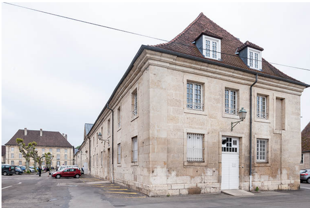
Bâtiment restauration-externat, pignon sud.
