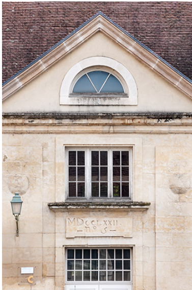
Avant-corps du bâtiment atelier -logement : détails Phot. Jérôme Mongreville IVR43_20143900289NUC4A
