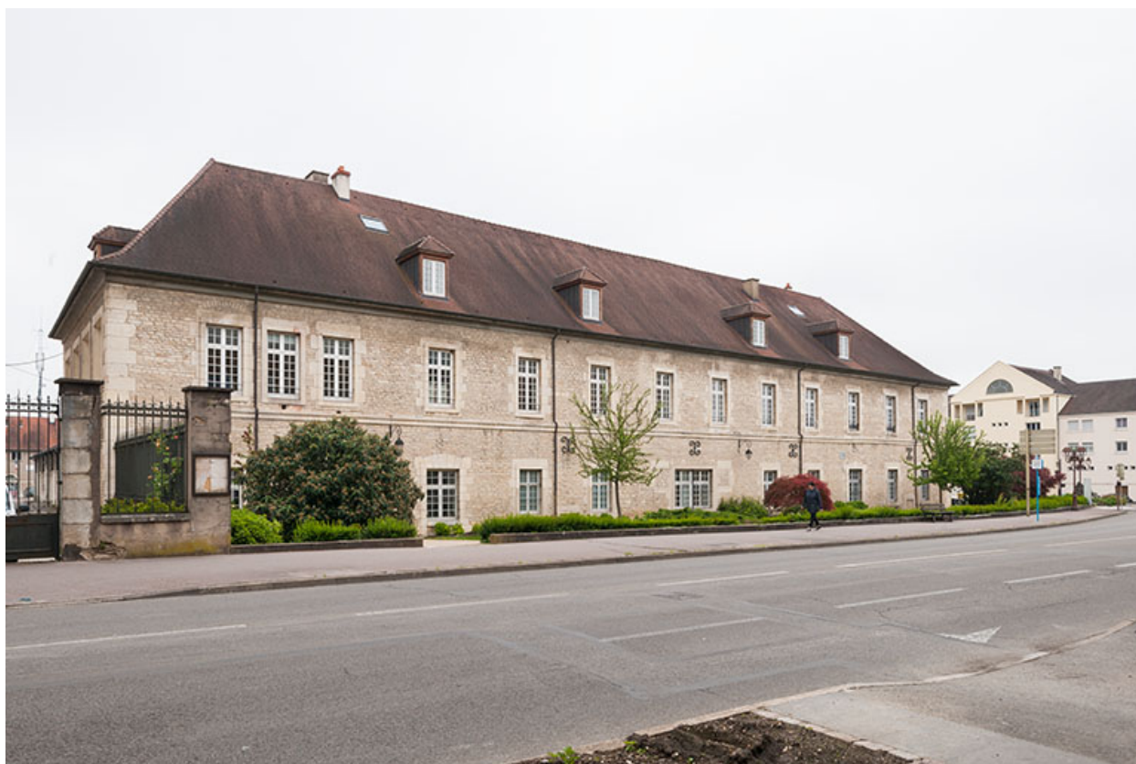
Atelier-externat : façade sur la rue des Arènes.
