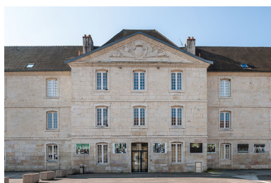
Externat-administration : avant-corps central de la façade antérieure, place Précipiano. Phot. Jérôme Mongreville IVR43_20143900271NUC4A
