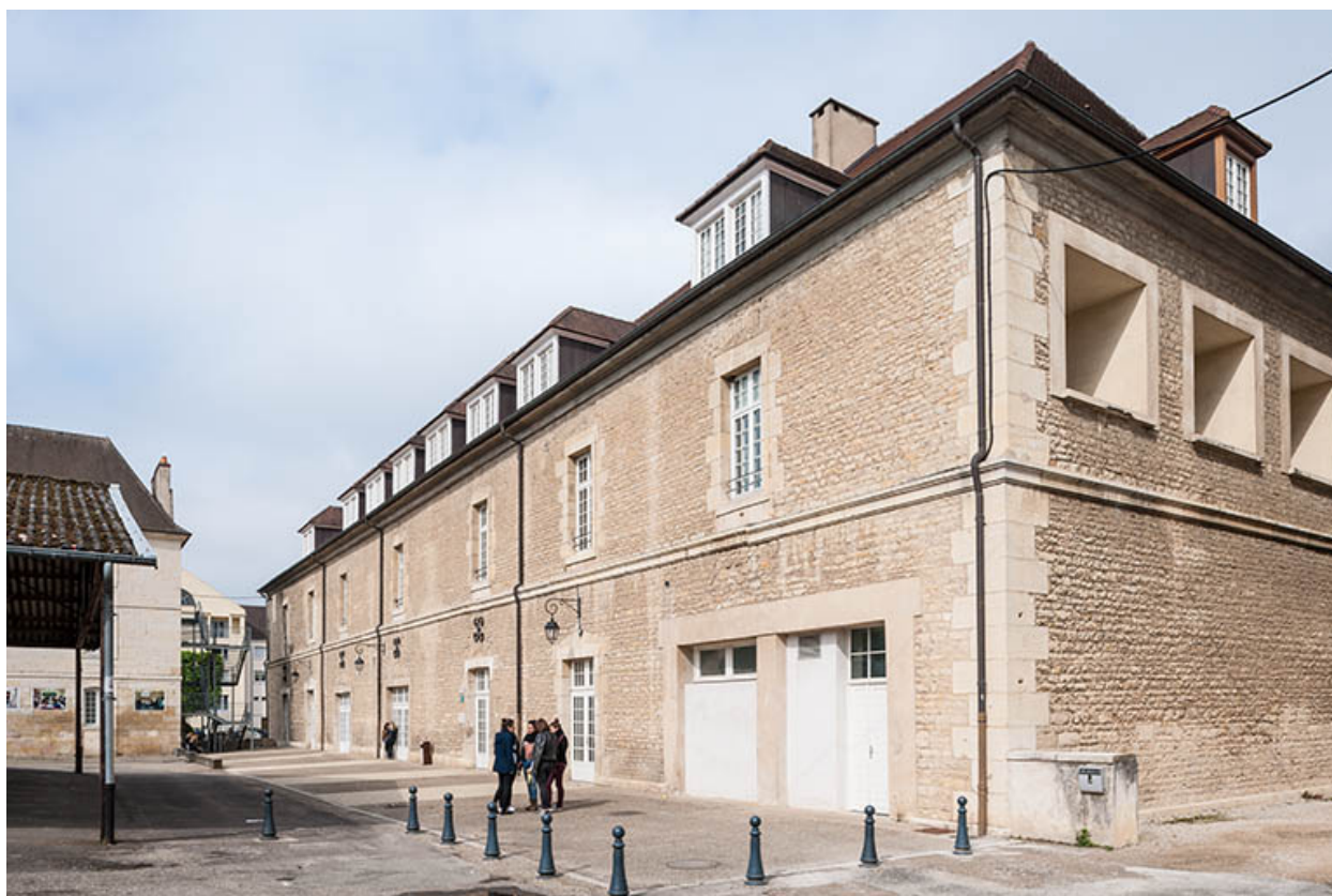
Atelier-externat : façade antérieure, vue 3/4.
