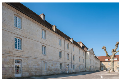
Externat : Vue 3/4 façade antérieure, place Précipiano. Phot. Jérôme Mongreville IVR43_20143900273NUC4A
