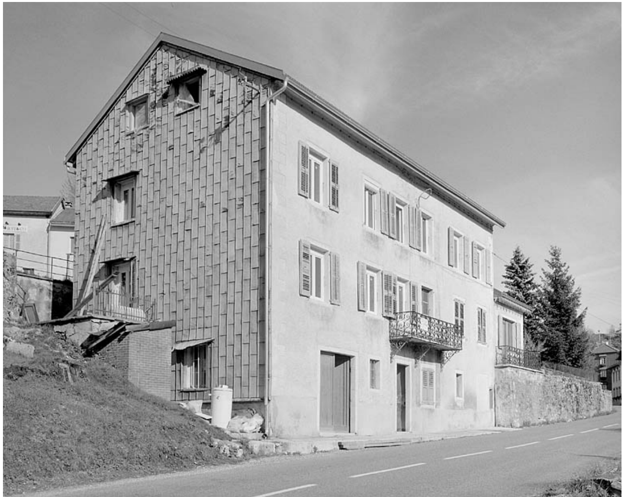
Façade antérieure et face sud-ouest.
