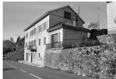
Façade antérieure et face nord-est. Phot. Jérôme Mongreville IVR43_19963901647X
