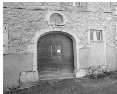
Bureau : porte dans le mur pignon nord-ouest. Phot. Jérôme Mongreville IVR43_19923900813X
