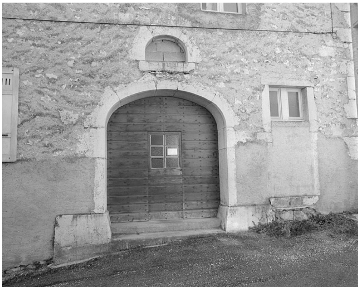
Bureau : porte dans le mur pignon nord-ouest.
