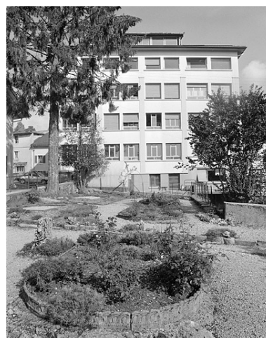
Parc et façade latérale de l'usine (E). Phot. Jérôme Mongreville IVR43_19923900814X
