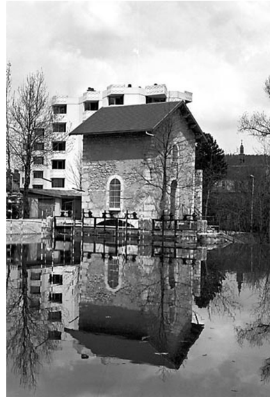
Bâtiment de l'écluse. Phot. Yves Sancey IVR43_19802500153X
