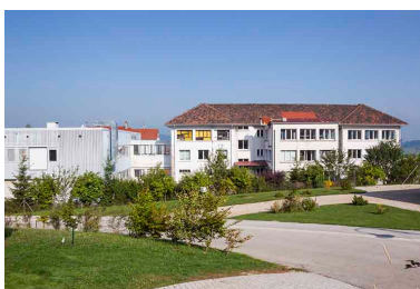
Ateliers de 1952 et 1970-1971 : façade postérieure. Phot. Yves Sancey IVR43_20132501124NUC2A
