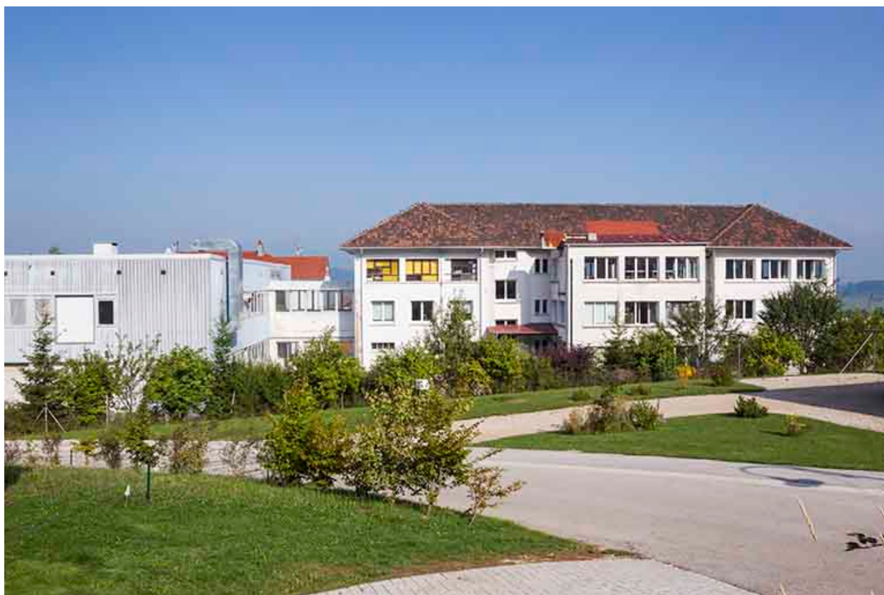
Ateliers de 1952 et 1970-1971 : façade postérieure.
