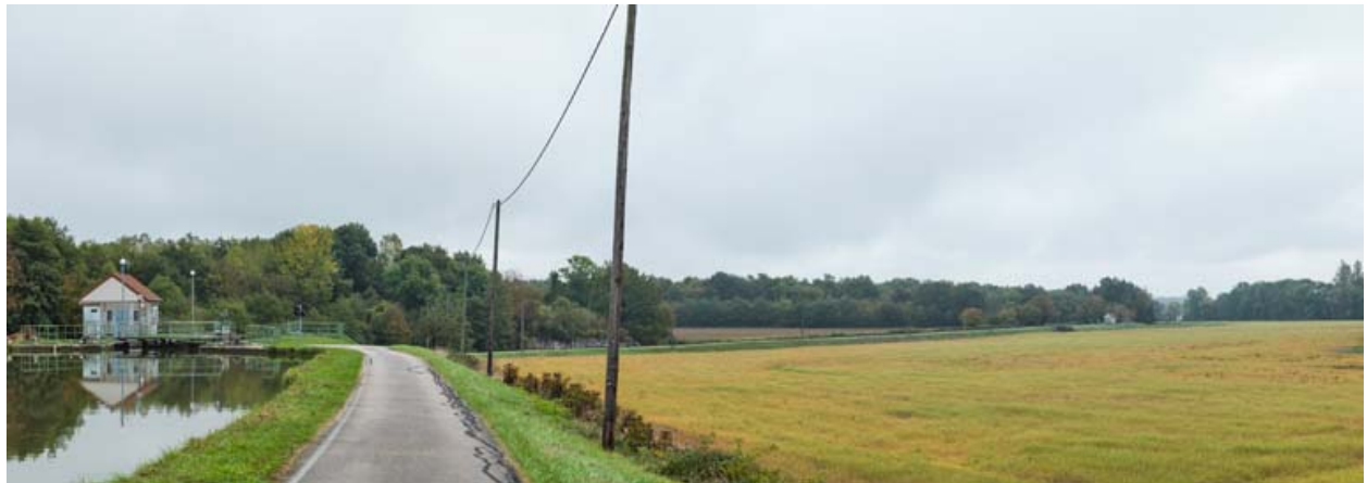
Vue d'ensemble du site d'écluse.
