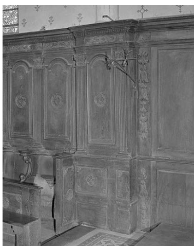
Détail. Phot. Yves Sancey IVR43_19743901266X
