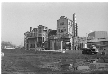
Les chaufferies, pignons sud.
