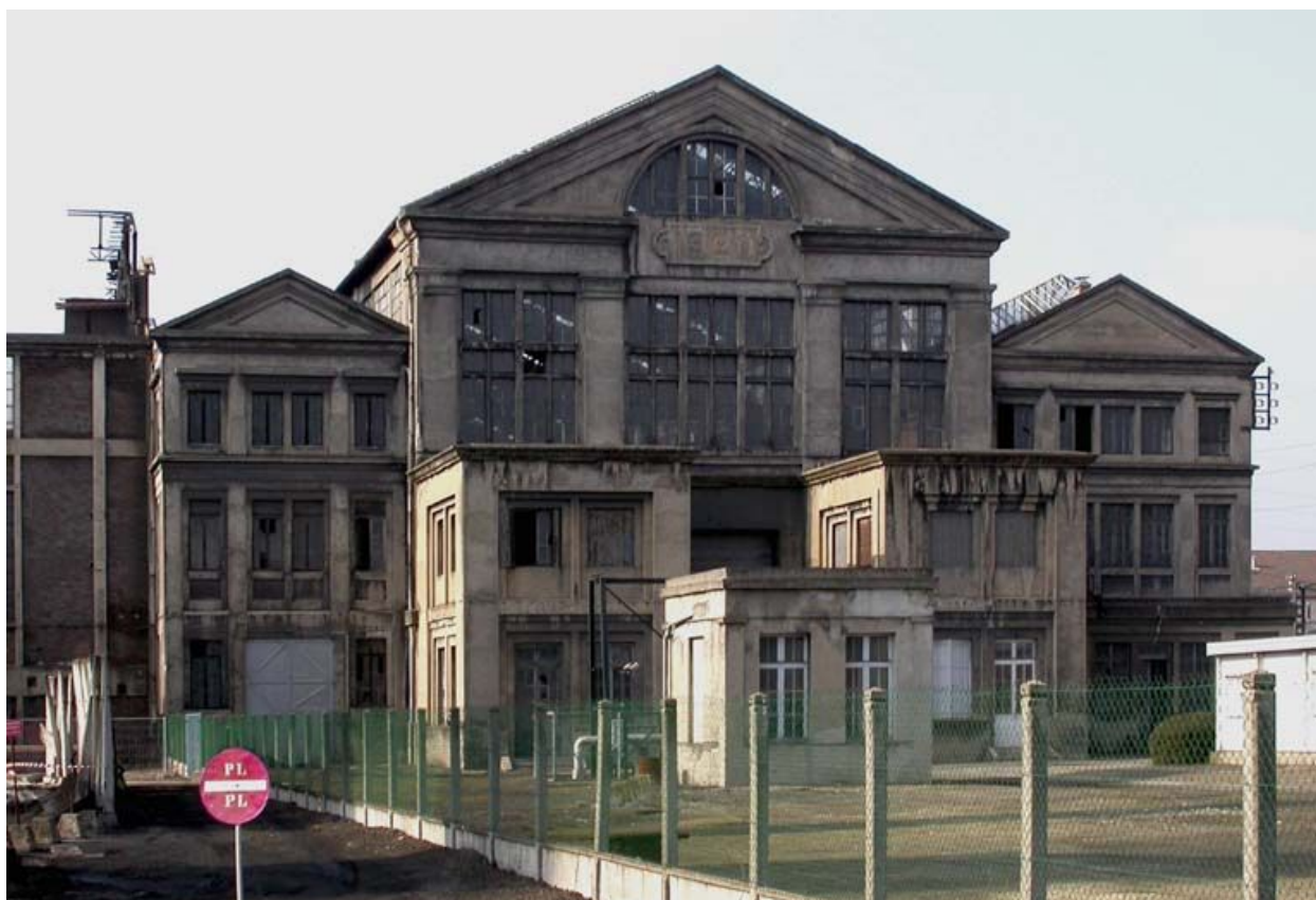
Elévation principale du bâtiments des alternateurs.
