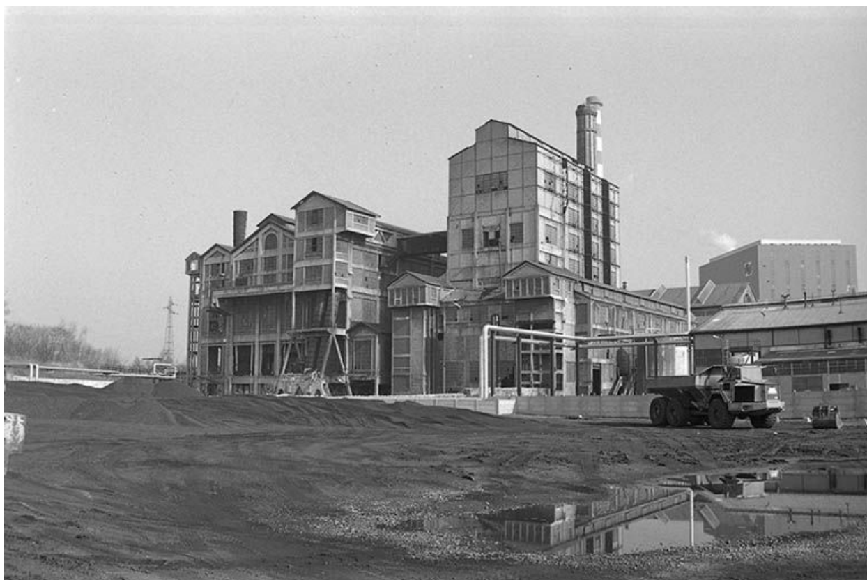
Les chaufferies, pignons sud.
