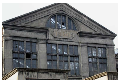
Elévation principale du bâtiments des alternateurs, détail. Phot. Alain Morelière IVR26_20047100006NUC2A
