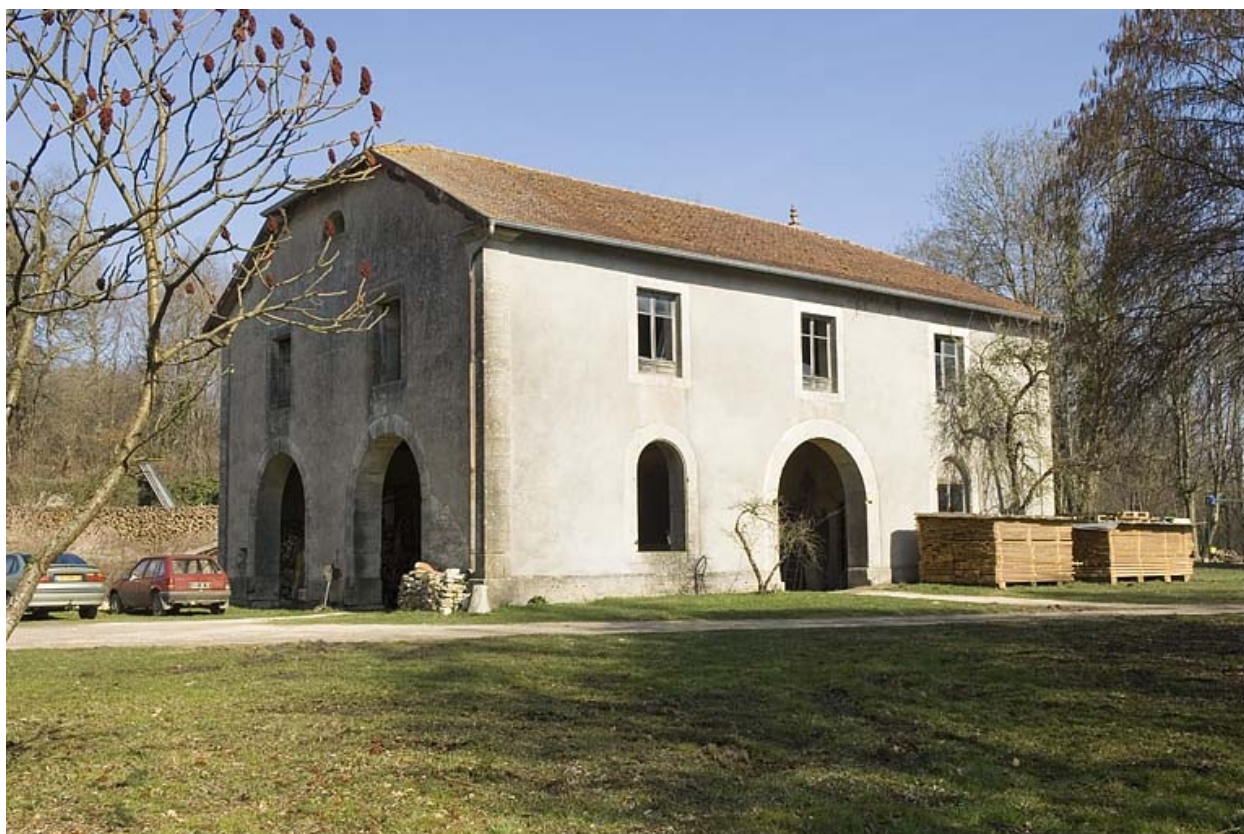
Bâtiment du haut fourneau depuis le sud.
