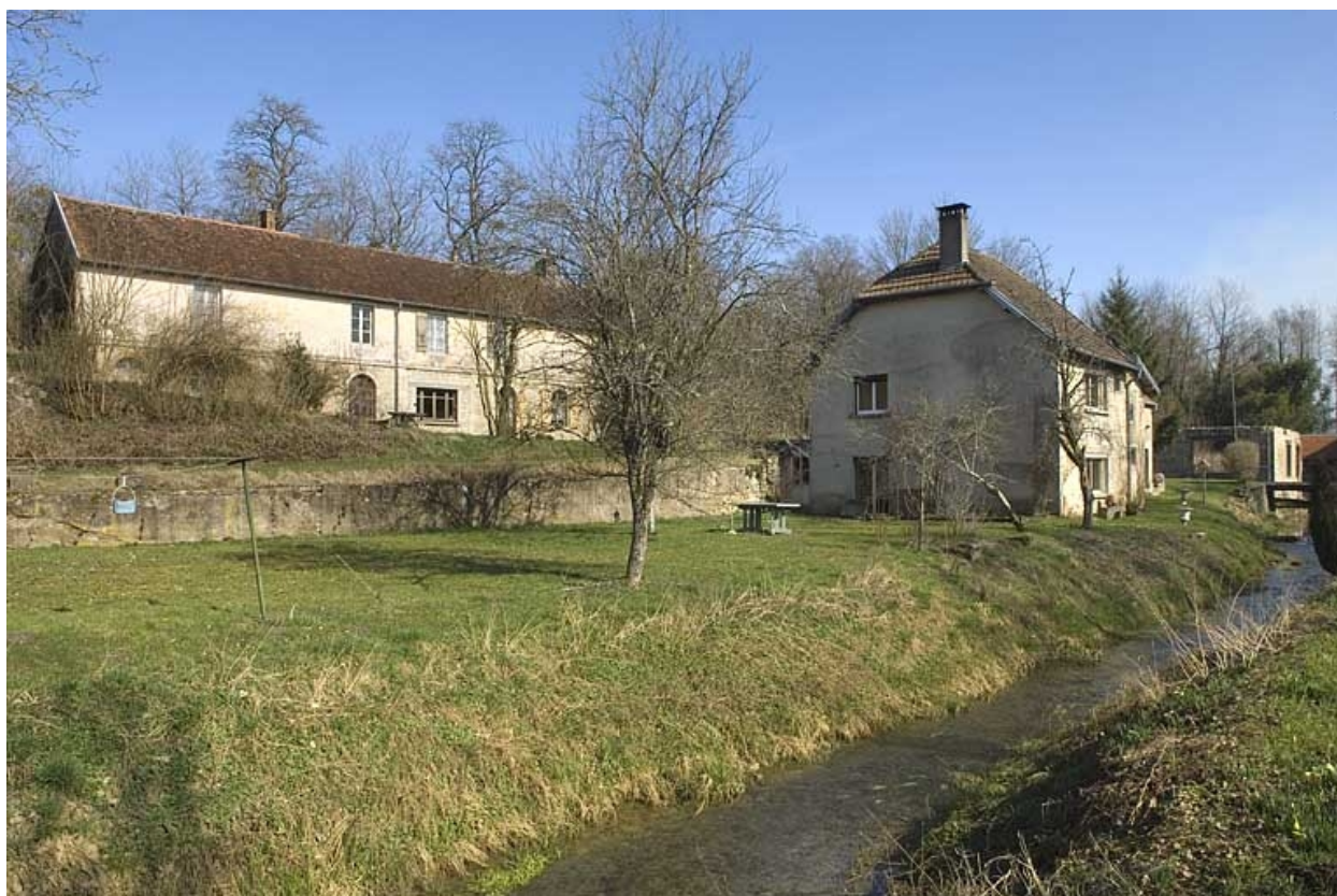
Vue d'ensemble des logements depuis le sud-ouest.
