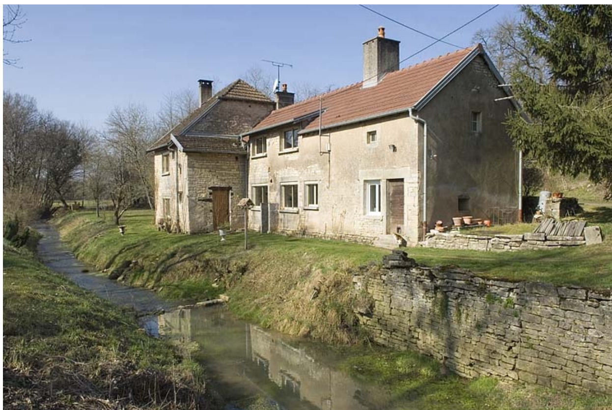
Logement depuis le bief de dérivation.
