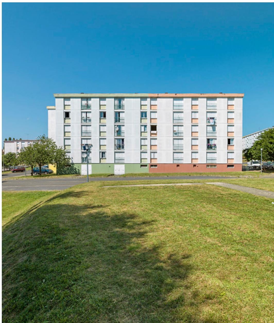
Bâtiment B-5, façade postérieure.
