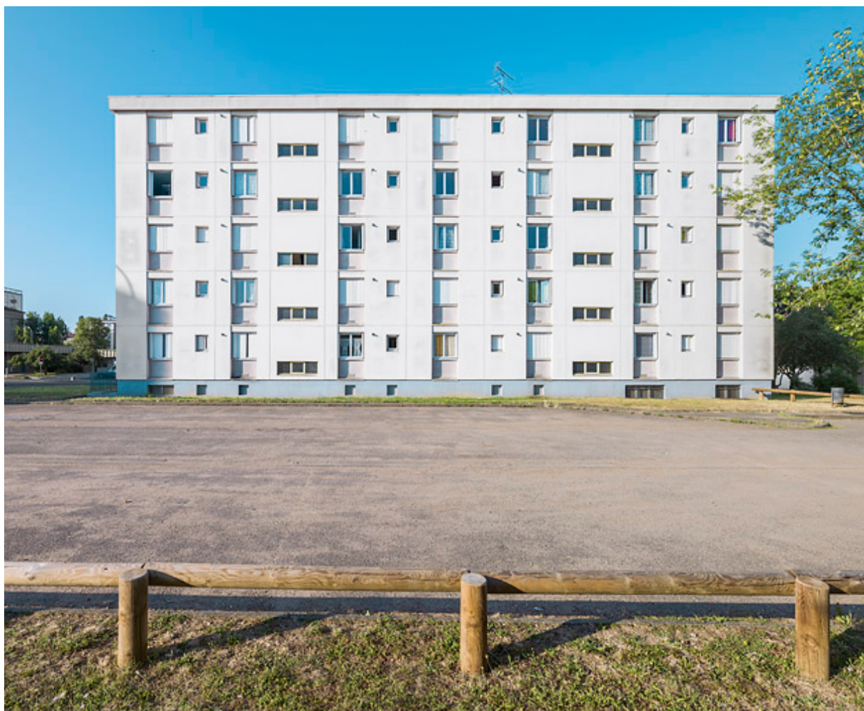
Bâtiment B-1, façade postérieure nord.
