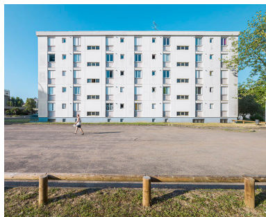
Bâtiment B-1, façade postérieure nord. Phot. Thierry Kuntz IVR26_20155800053NUC4A
