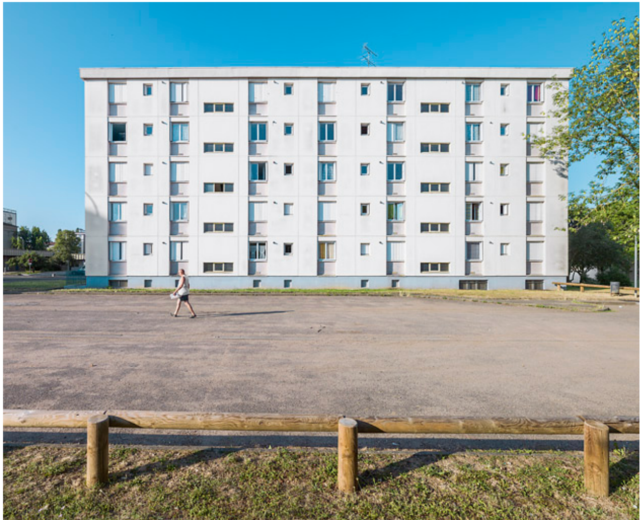
Bâtiment B-1, façade postérieure nord.
