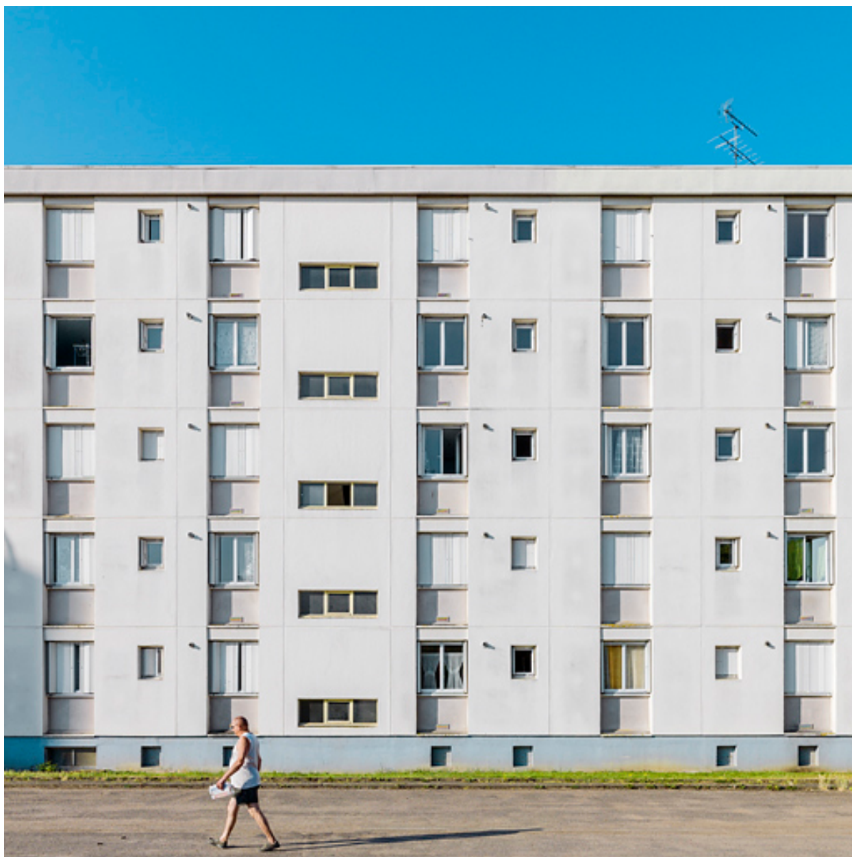
Bâtiment B-1, façade postérieure nord.
