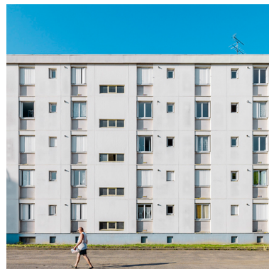
Bâtiment B-1, façade postérieure nord. Phot. Thierry Kuntz IVR26_20155800055NUC2A
