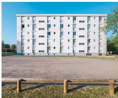
Bâtiment B-1, façade postérieure nord. Phot. Thierry Kuntz IVR26_20155800054NUC4A
