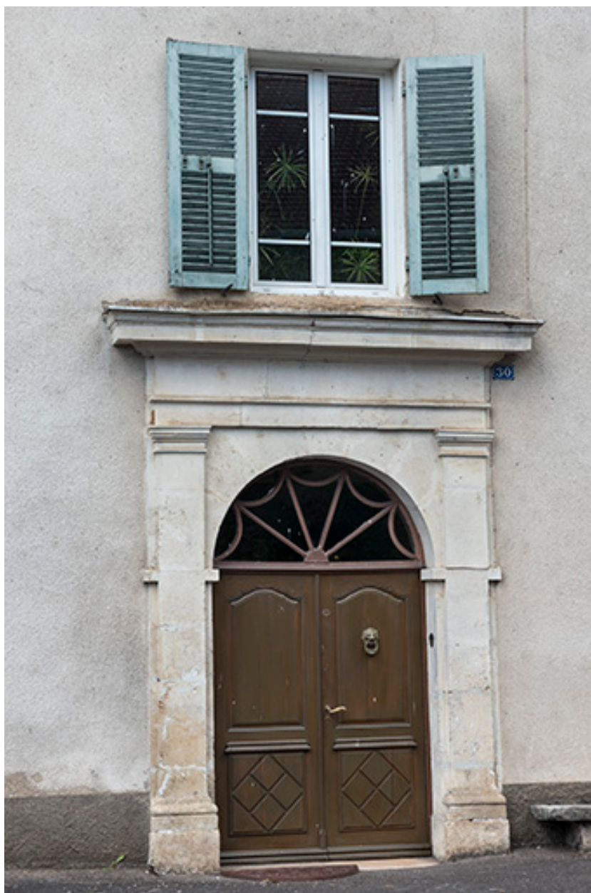
Façade antérieure : détail de la porte d'entrée.
