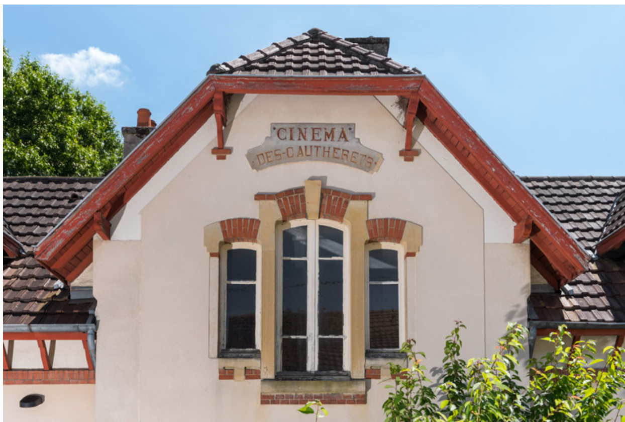
Façade antérieure : mur pignon, avec inscription.
