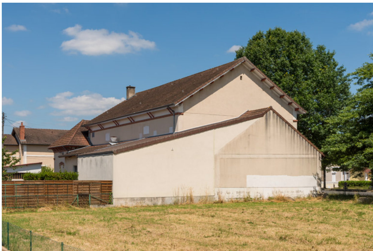
Façades postérieure et latérale droite.
