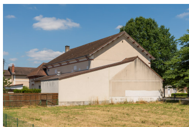
Façades postérieure et latérale droite.
