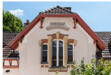
Façade antérieure : mur pignon, avec inscription.
