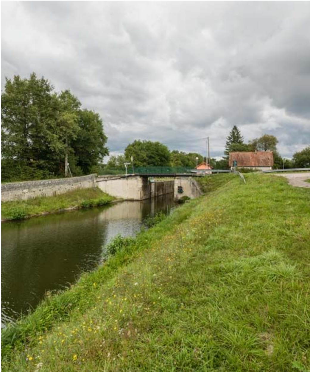
Vue d'ensemble du pont.
