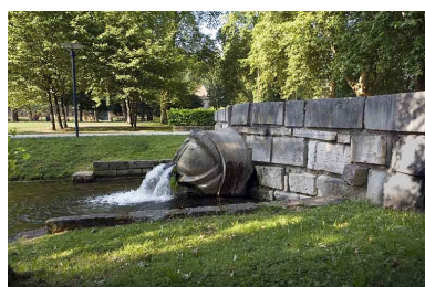
Vue d'ensemble de profil, à droite. Phot. Yves Sancey IVR43_20062500227NUCA
