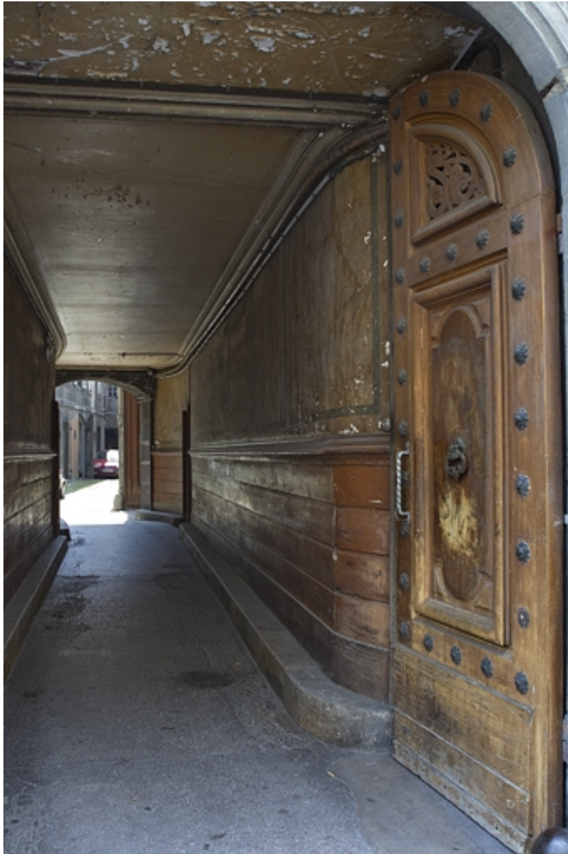
Vue d'ensemble du passage cocher depuis l'entrée.
