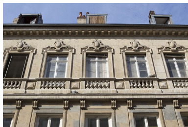
Détail des fenêtres du deuxième étage. Phot. Yves Sancey IVR43_20102501212NUC2A
