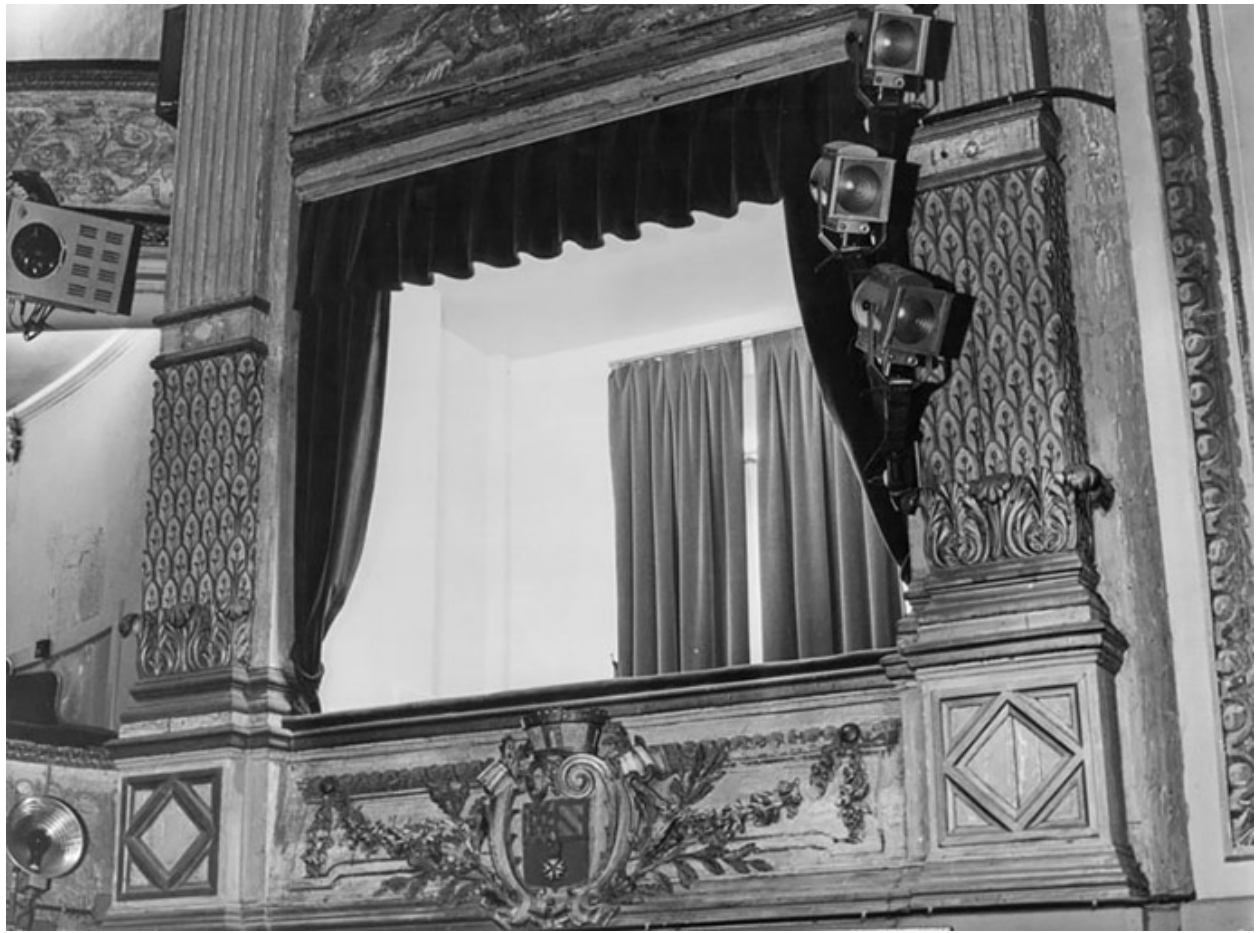
Loge du maire avant tx [travaux]. S.d. [1969].
