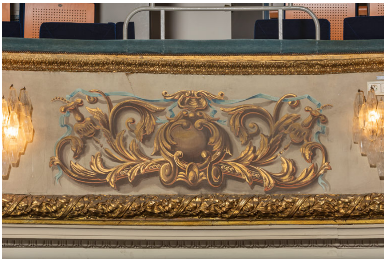
Décor peint du garde-corps du 2e balcon.
