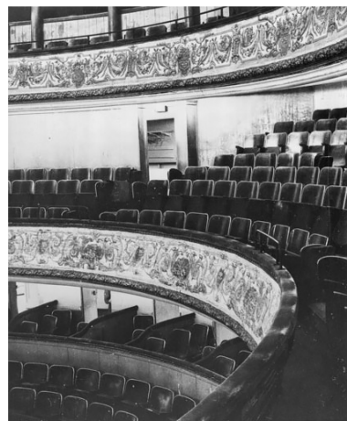
[2e balcon, avant travaux]. S.d. [1969].
