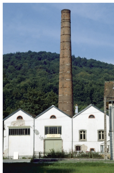
Salle des machines, chaufferie et cheminée. Phot. Yves Sancey IVR43_19999000295ZA
