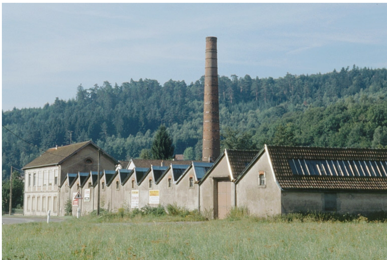
Façade sur la route départementale 465.
