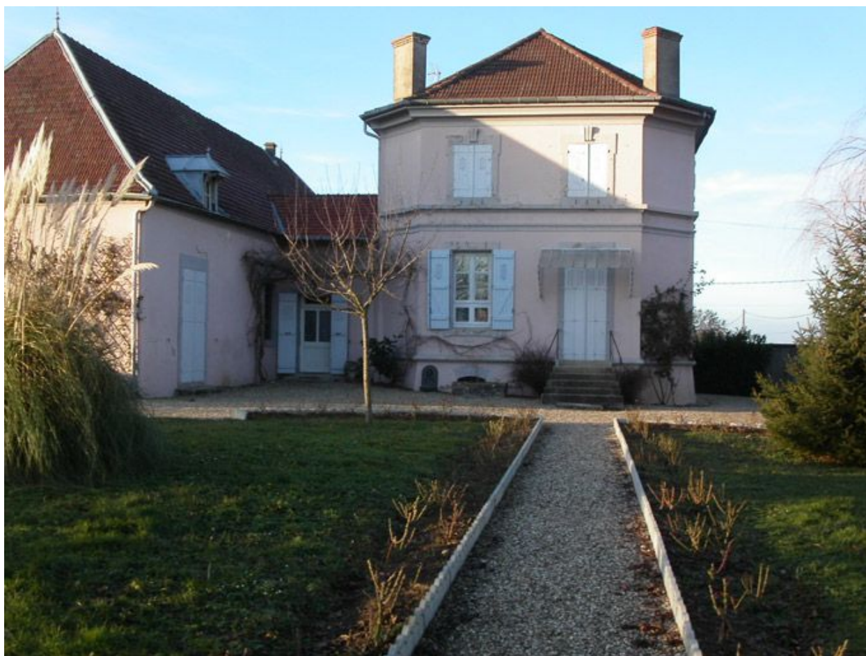
Vue d'ensemble de la façade.
