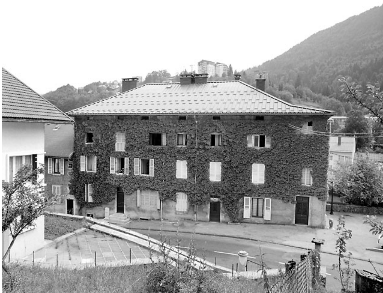
Bâtiment 11-15 rue Pasteur : façade antérieure.
