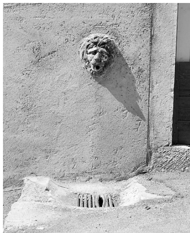
Bâtiment 3 rue Etienne Dolet : point d'eau. Phot. Yves Sancey IVR43_20033900892X
