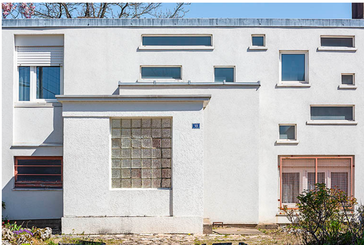
Presbytère. Détail de la façade sud-ouest.
