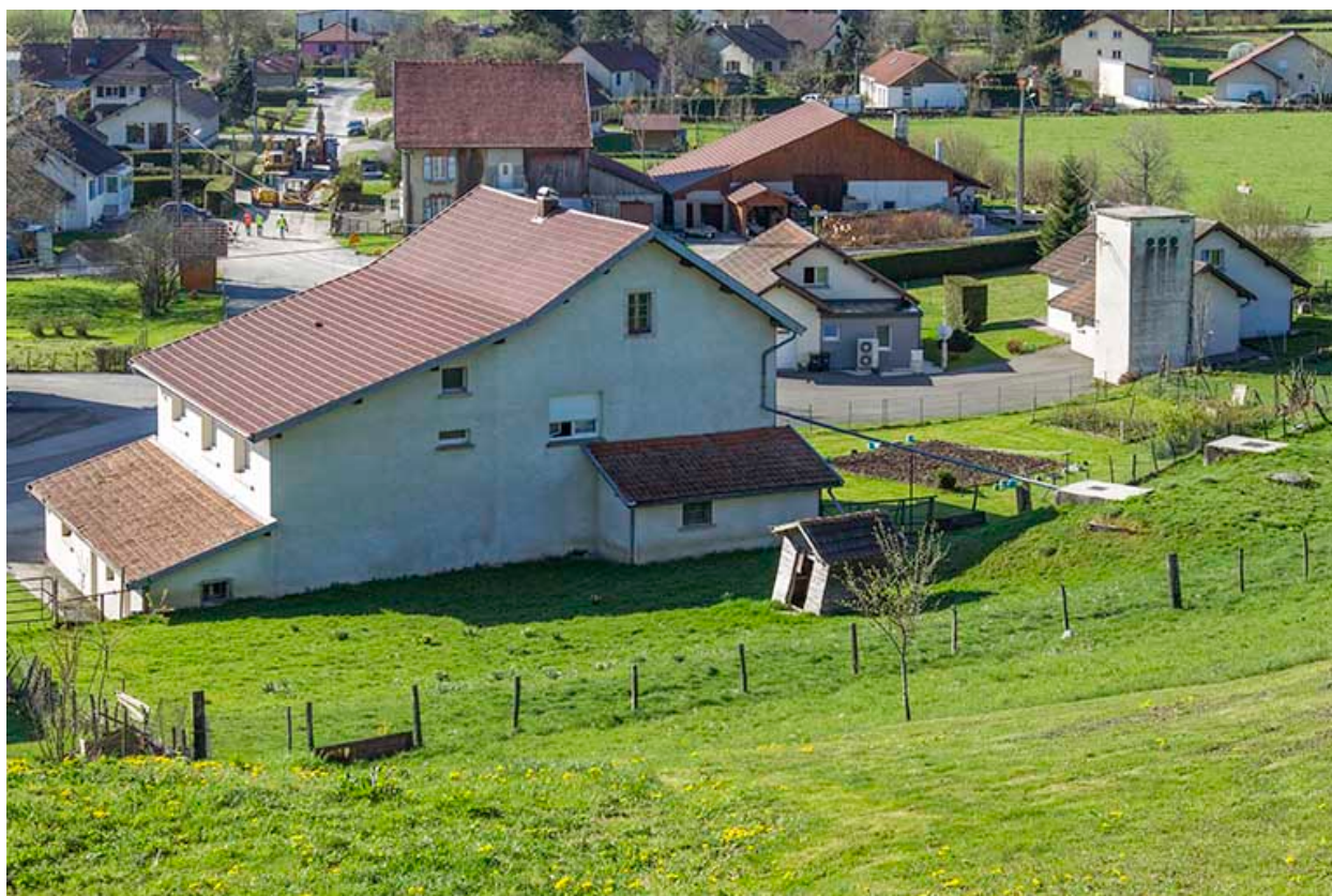
Elévation postérieure et citernes.
