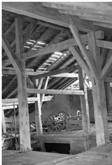
Détail de la charpente. Phot. Gilbert Poinot IVR43_19752500961Z
