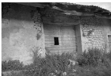
Porte de grange. Phot. Gilbert Poinot IVR43_19752500945Z
