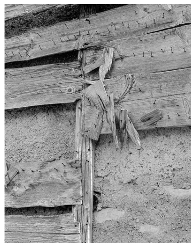
Détail : la "talvanne". Phot. Dominique Dominguez IVR43_19792500060X
