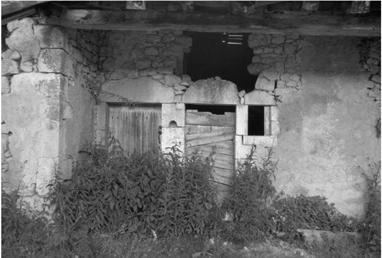
Porte d'entrée du couloir, porte d'entrée d'habitation.
