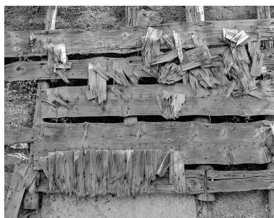
Détail : la "talvanne". Phot. Dominique Dominguez IVR43_19792500058X
