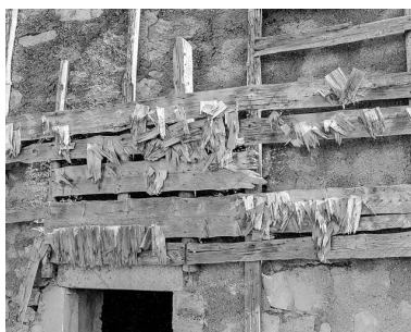
Détail : la "talvanne". Phot. Dominique Dominguez IVR43_19792500059X
