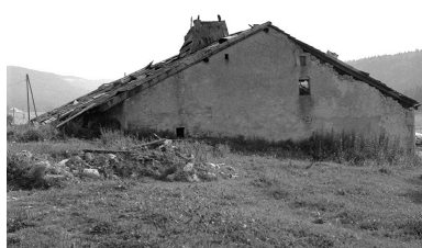
Façade latérale gauche. Phot. Gilbert Poinot IVR43_19752500942Z
