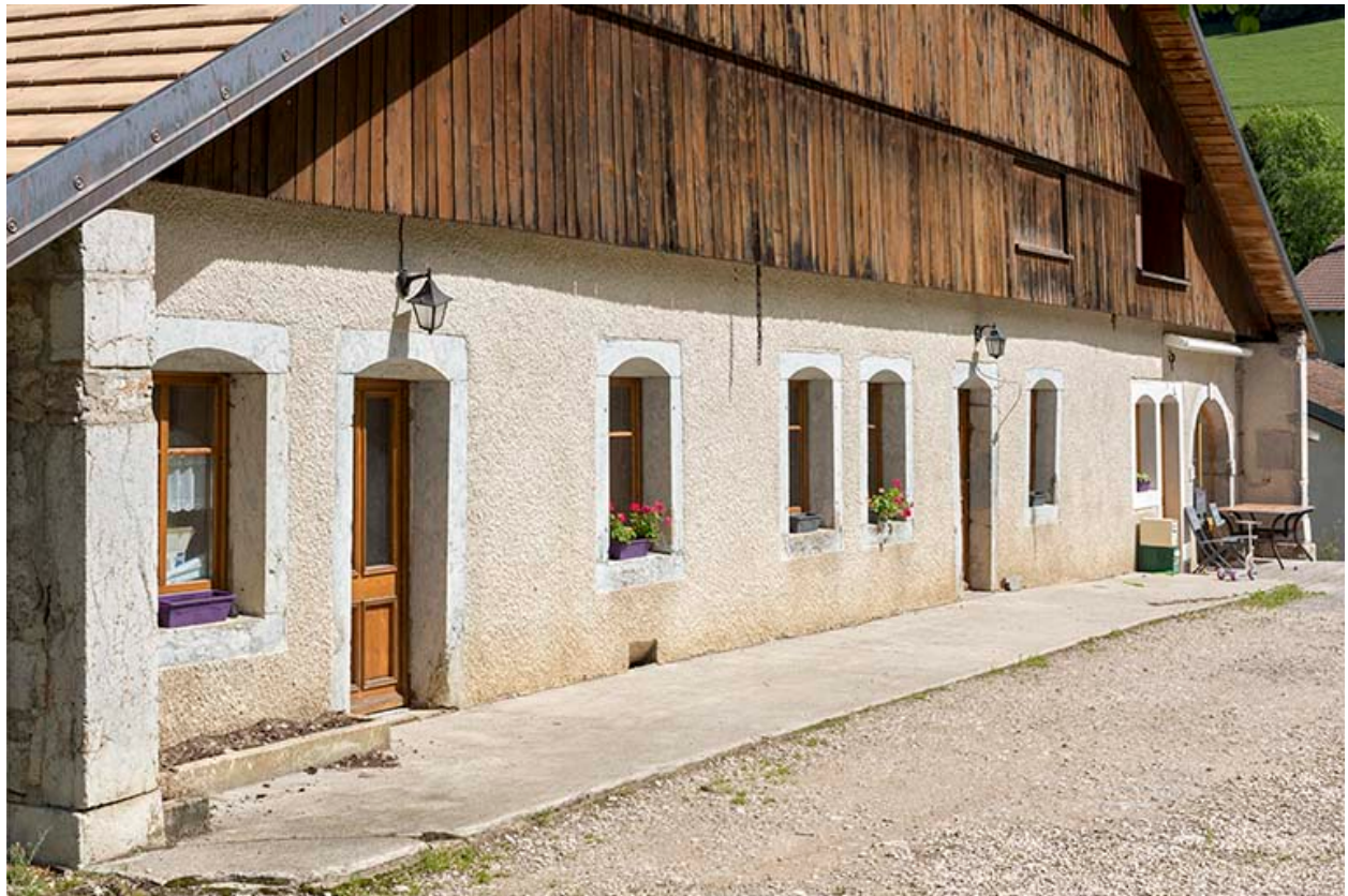
Façade antérieure, vue en enfilade.
