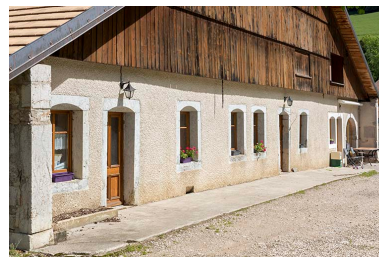
Façade antérieure, vue en enfilade. Phot. Sonia Dourlot IVR43_20172500603NUC4A
