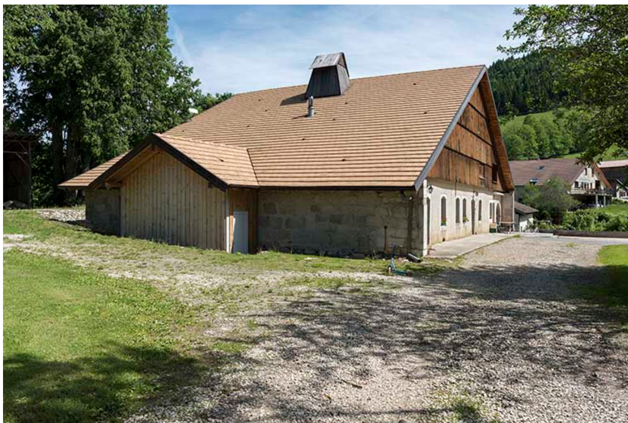
Façades antérieure et latérale gauche.
