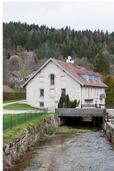
Vue d'ensemble depuis l'amont. Phot. Jérôme Mongreville IVR43_20162500285NUC4A
