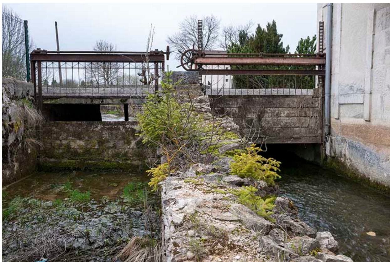
Vestiges du local des turbines.
