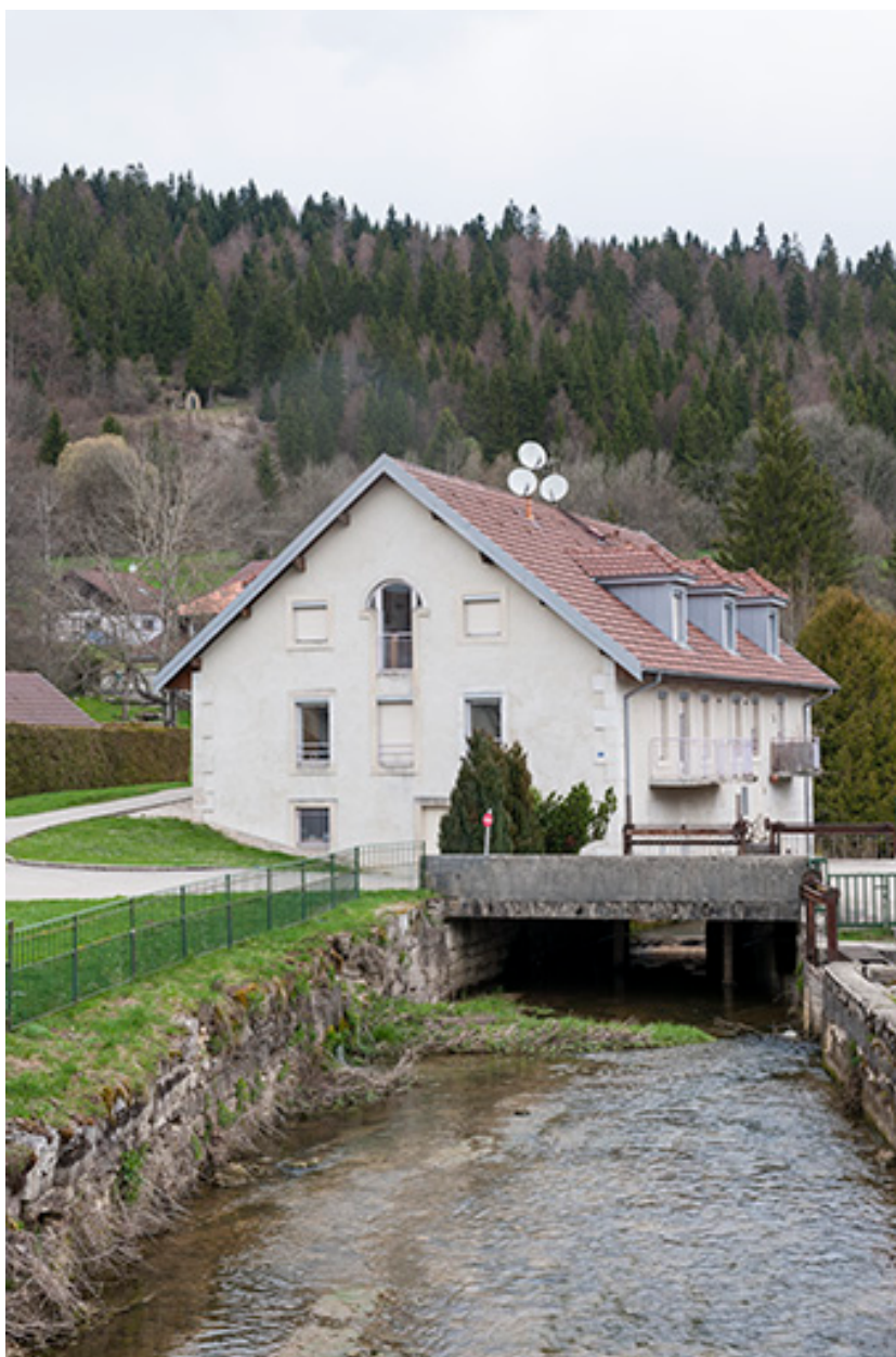
Vue d'ensemble depuis l'amont.
