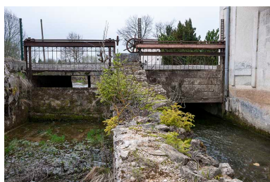
Vestiges du local des turbines. Phot. Jérôme Mongreville IVR43_20162500288NUC4A
