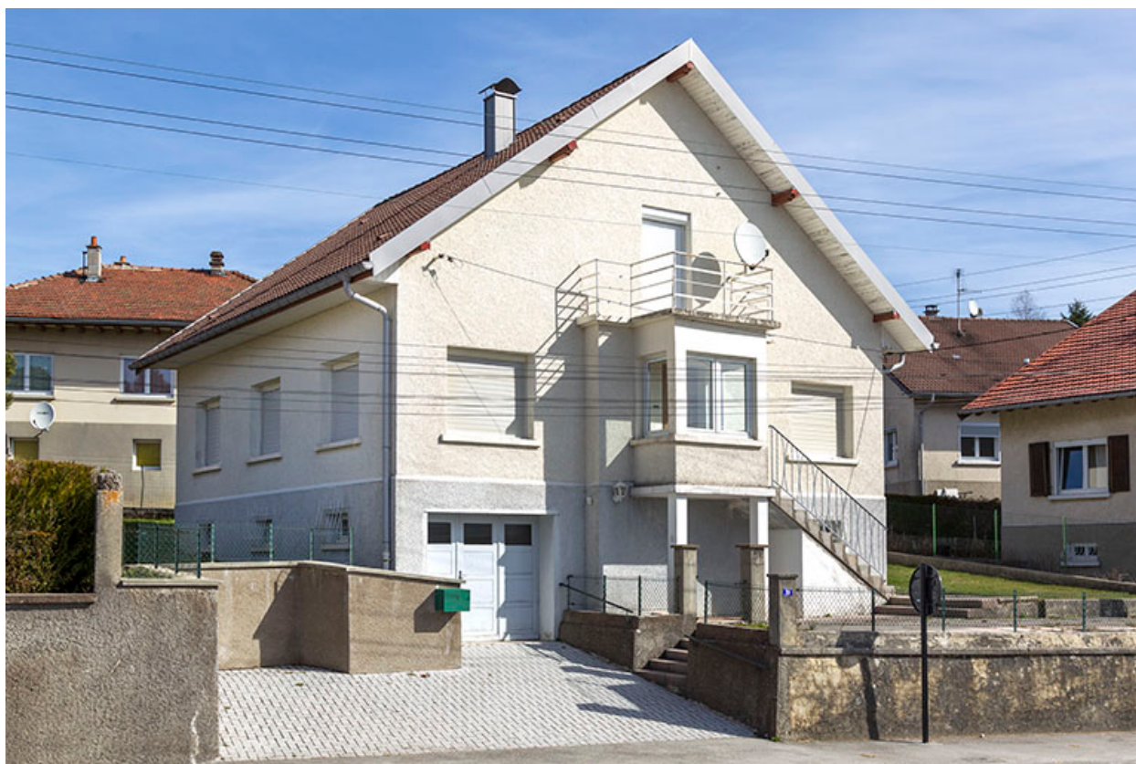
Façades antérieure et latérale gauche.
