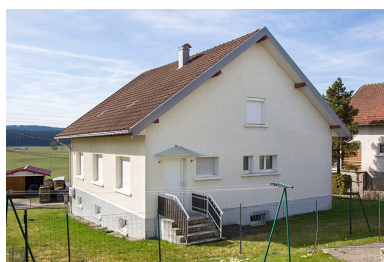
Façades postérieure et latérale droite.
