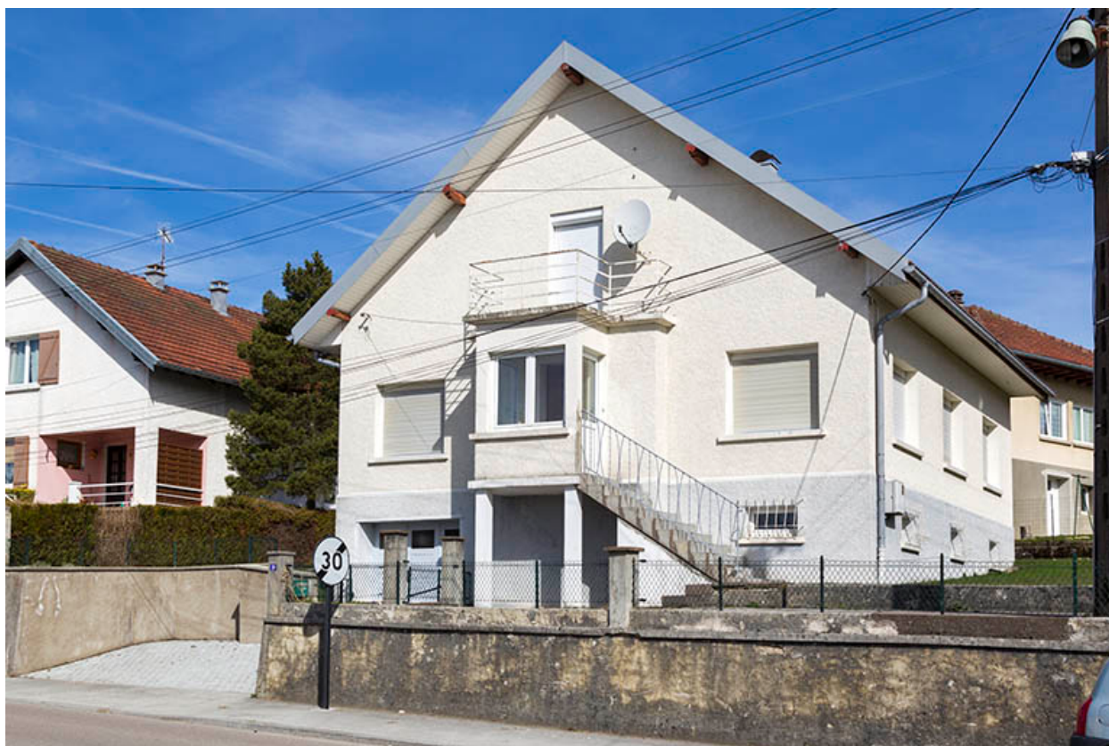
Façades antérieure et latérale droite.
