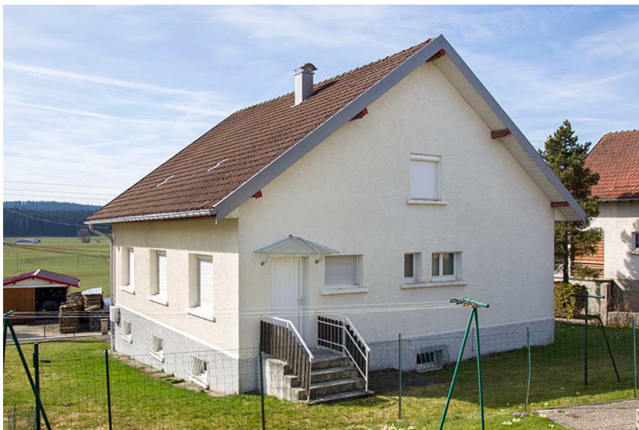
Façades postérieure et latérale droite.
