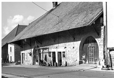
Ferme située 16 Grande Rue. Phot. Yves Sancey IVR43_19802501036X
