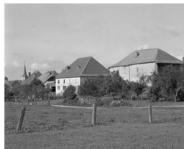
Vue rapprochée Phot. Yves Sancey IVR43_19802501021X
