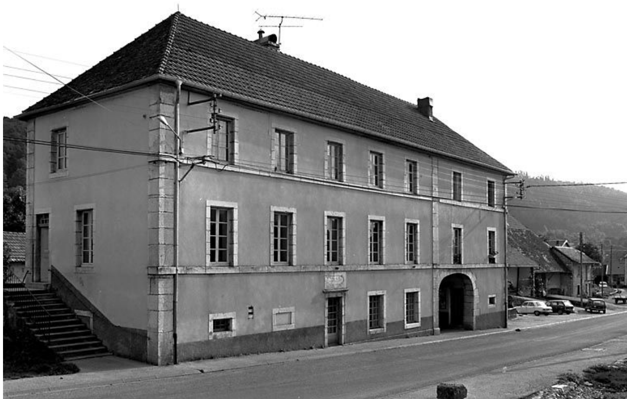
Mairie-école située Grande Rue.
