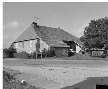
Ferme située 54 Grande Rue. Phot. Yves Sancey IVR43_19802501037X
