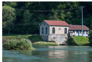
Vue de trois quarts depuis l'aval. Phot. Jérôme Mongreville IVR43_20142501147NUC4A
