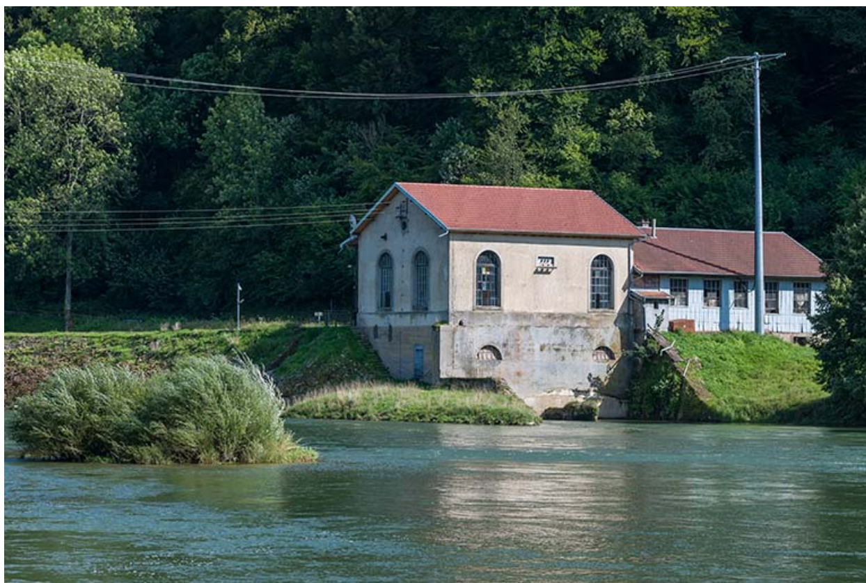
Vue de trois quarts depuis l'aval.
