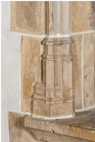
Détail : bases prismatiques des piédroits.
