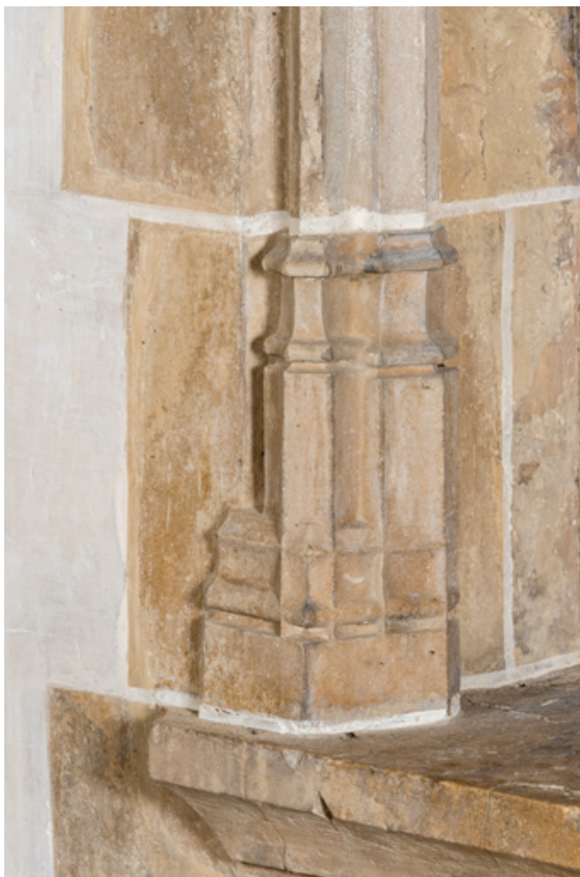
Détail : bases prismatiques des piédroits.
