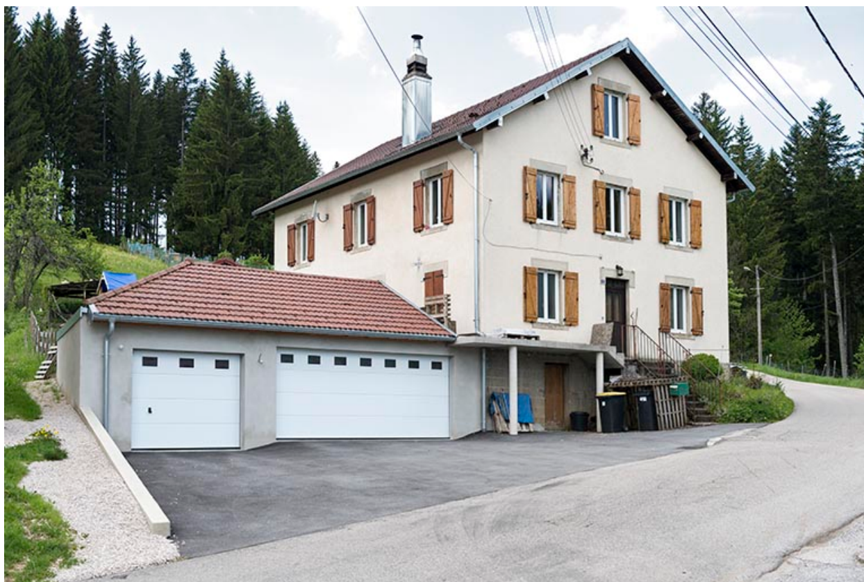
Façades antérieure et latérale gauche.
