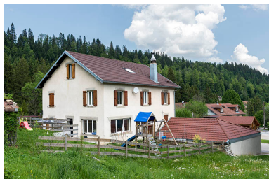
Façades postérieure et latérale gauche.
