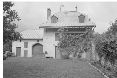
Façade antérieure. Phot. Jérôme Mongreville IVR43_19963900979X
