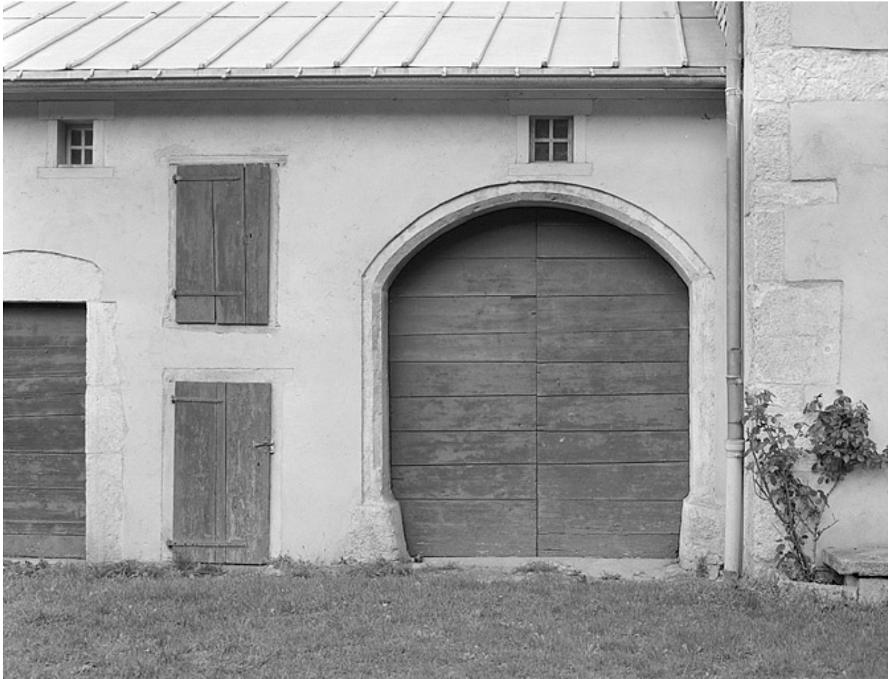
Porte d'accès aux communs.
