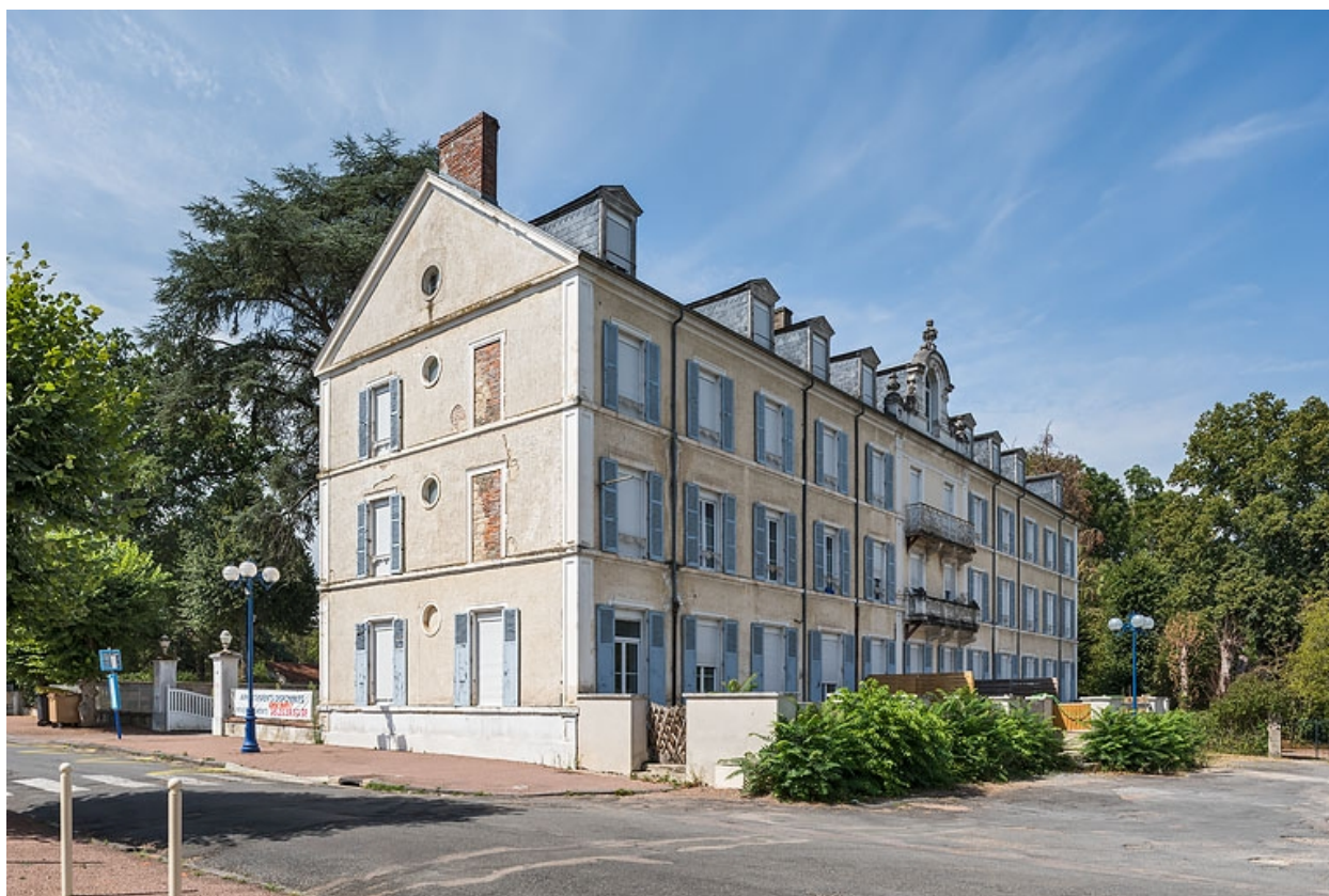
Façade nord du corps principal, vue en 2020.
