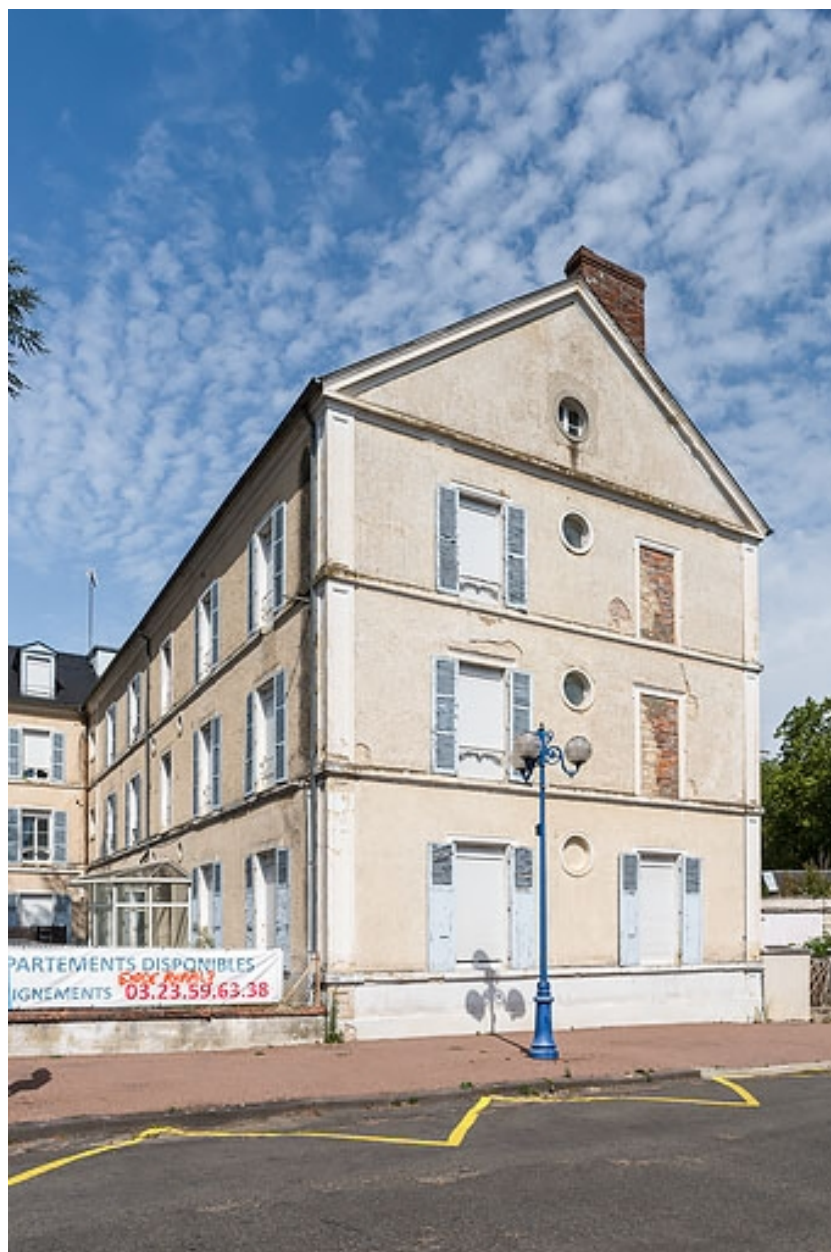
Façade est du corps principal, vue en 2020.
