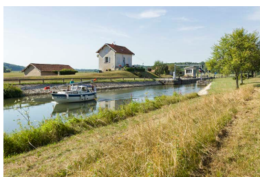
Le site d'écluse de Sceaux-sur-Saône. Phot. Sonia Dourlot IVR43_20157000776NUC2A
