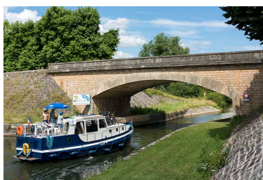
Le pont et son arc surbaissé. Phot. Sonia Dourlot IVR43_20167001863NUC4A
