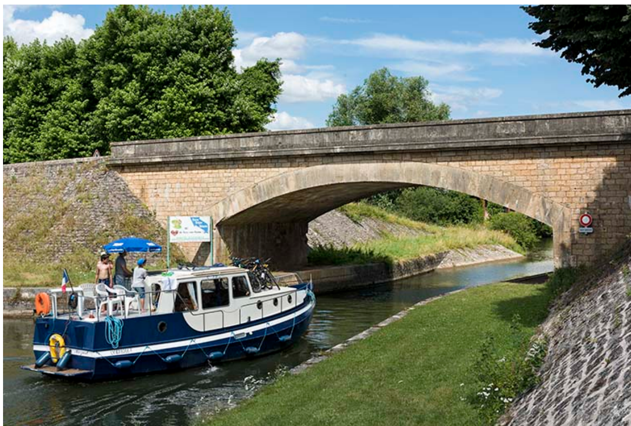
Le pont et son arc surbaissé.
