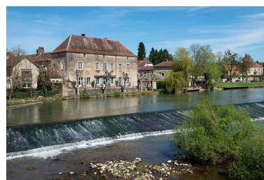
Le barrage dans le méandre de la Saône. Phot. Jérôme Mongreville IVR43_20187000692NUC4A
