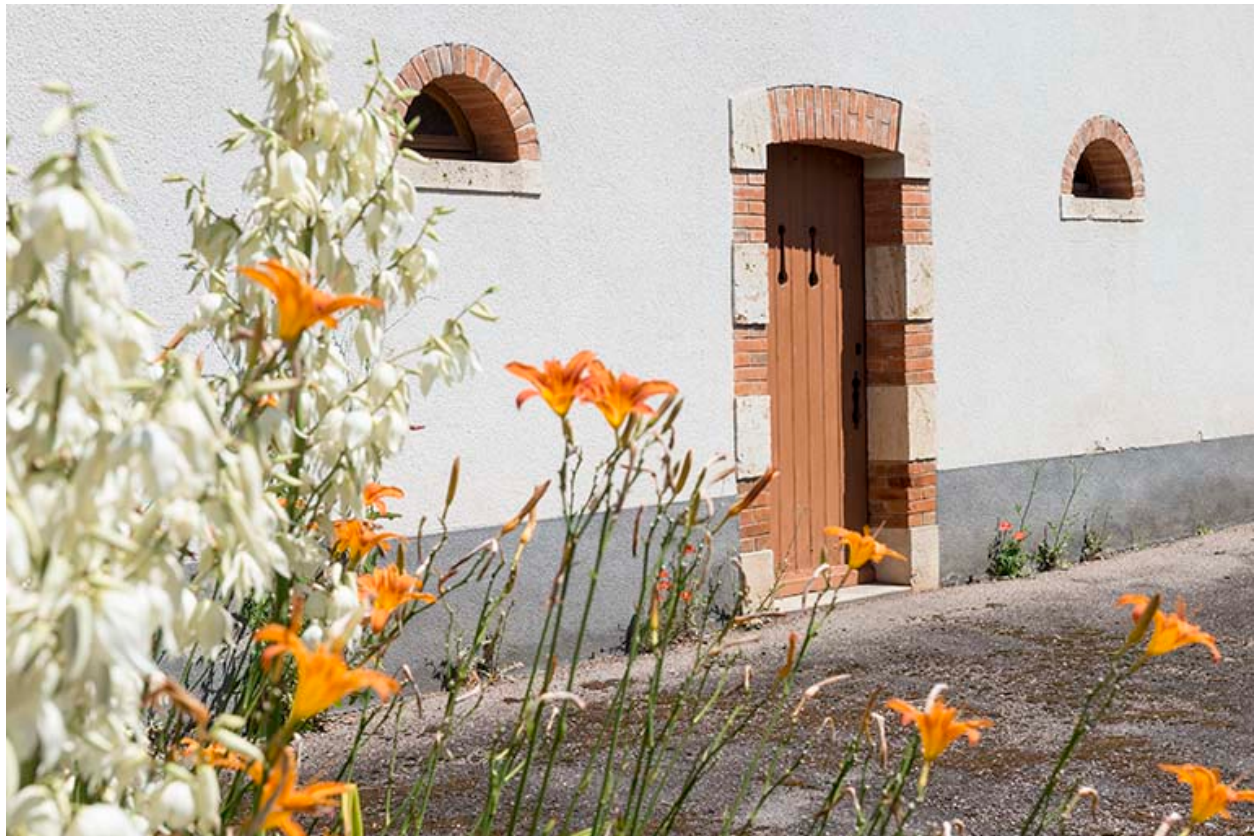
Les ouvertures latérales du garage.
