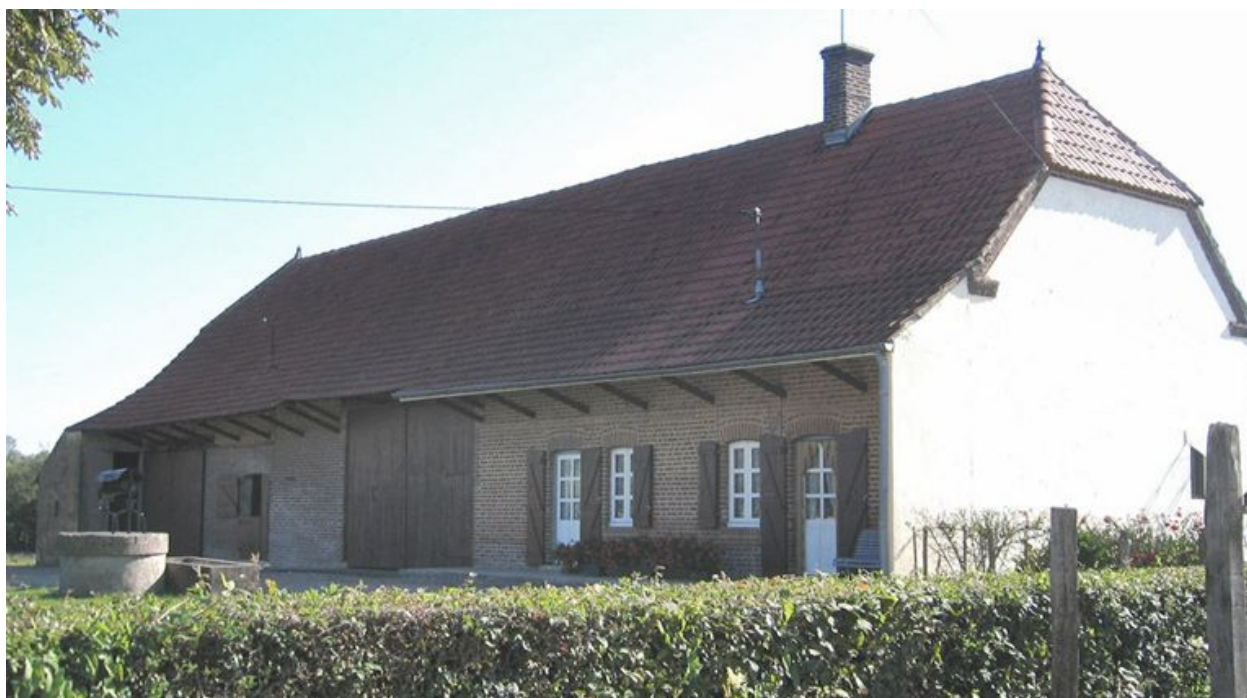
Vue d'ensemble de la façade.
