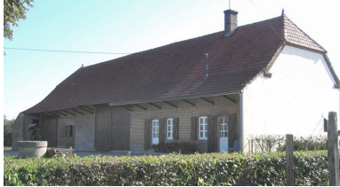
Vue d'ensemble de la façade.
