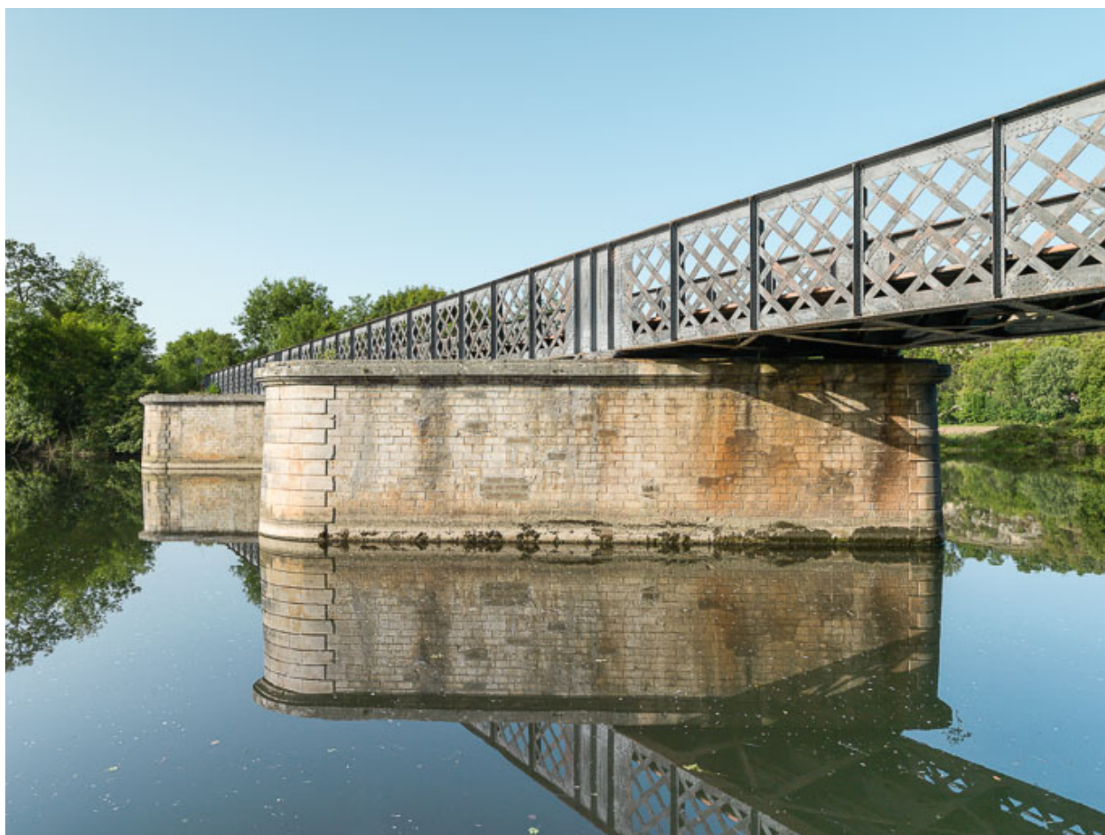
Vue du pont.
