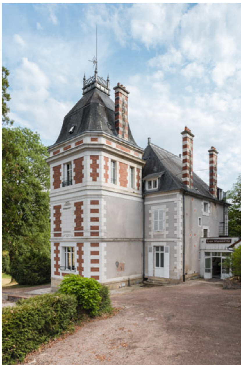
Pavillon nord, vue depuis le nord-est.
