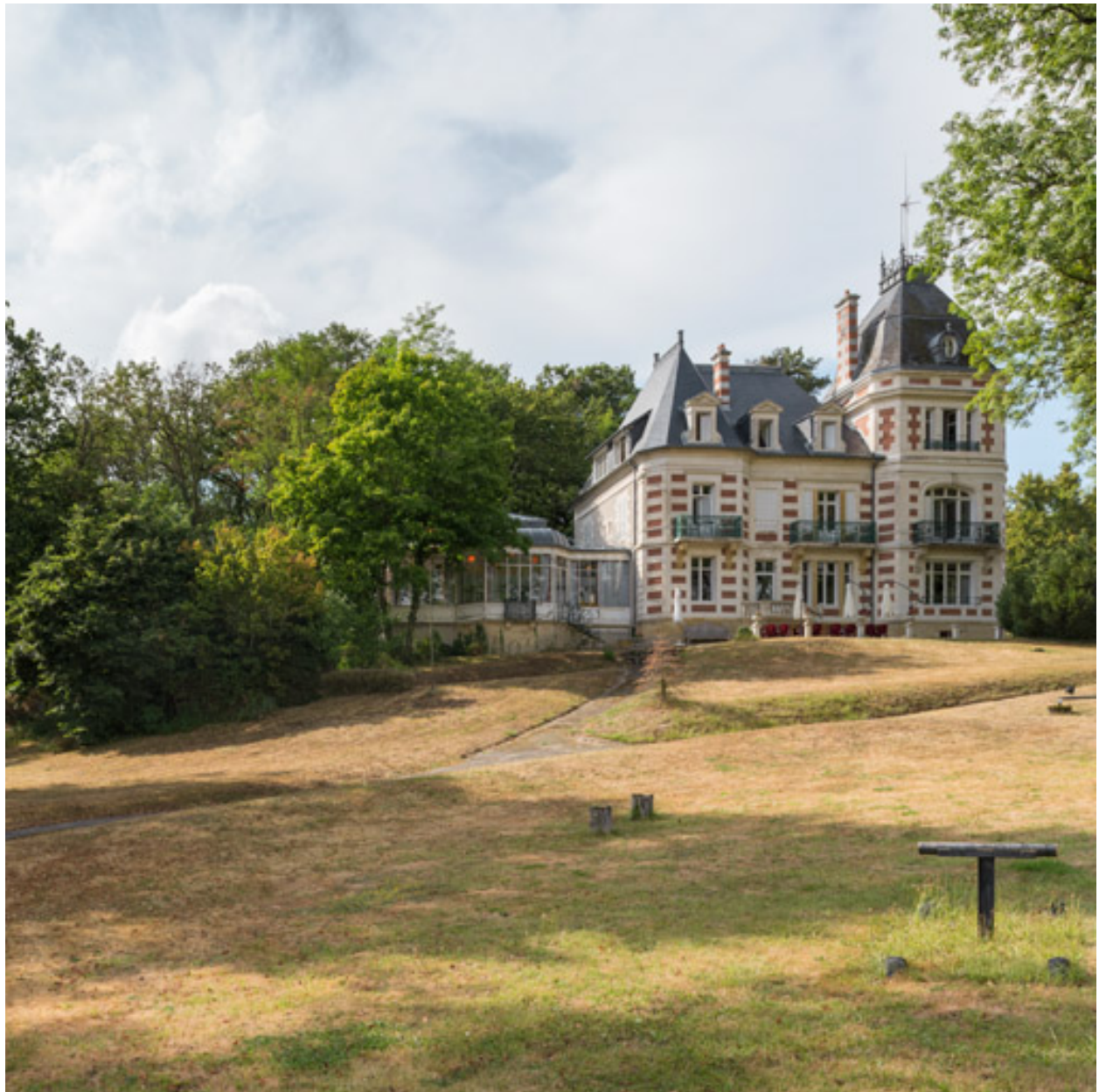
Façade, vue de trois-quarts depuis le sud.
