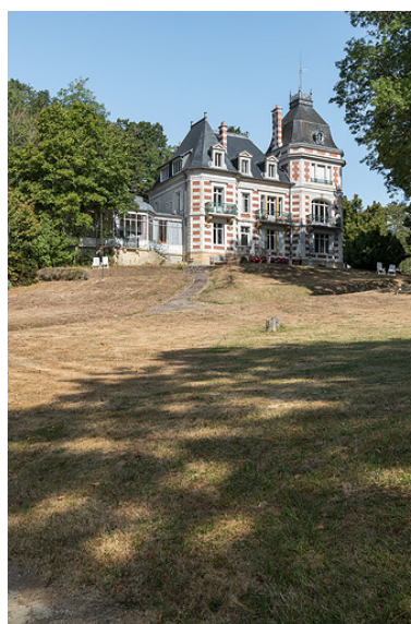
Façade, vue de trois- quarts depuis le sud. Phot. Pierre-Marie Barbe-Richaud IVR26_20195800670NUC4A
