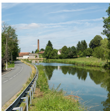
Vue d'ensemble d'aval. Phot. Pierre-Marie Barbe-Richaud IVR26_20137100480NUC2AQ
