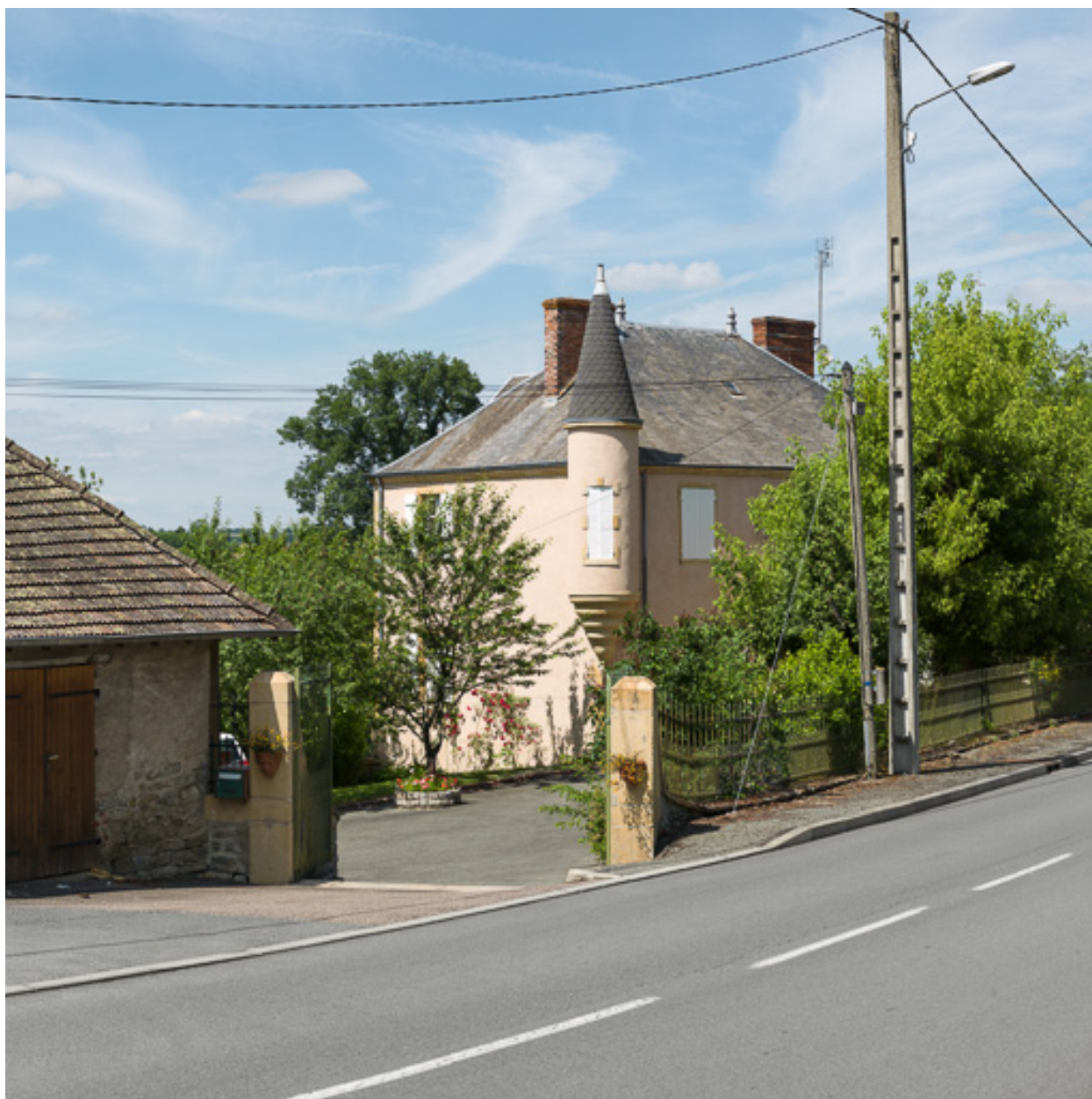
En amont du pont de Palignes, belle demeure à échauguettes.
