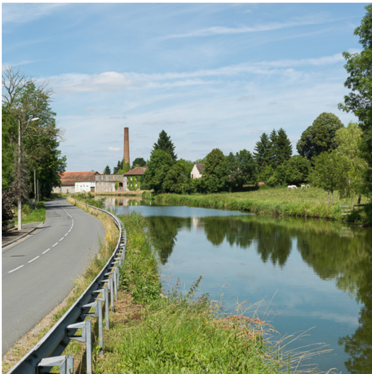
Vue d'ensemble d'aval.
