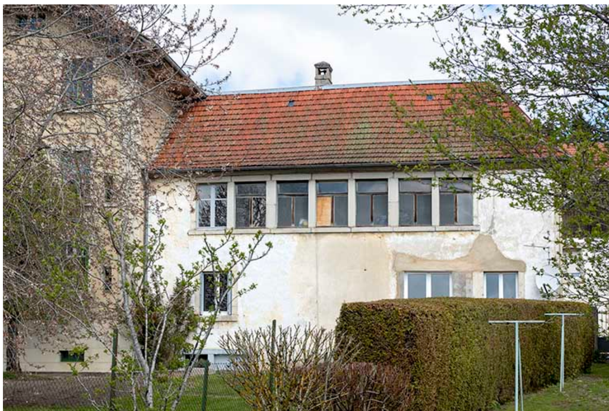
Façade postérieure de l'atelier.
