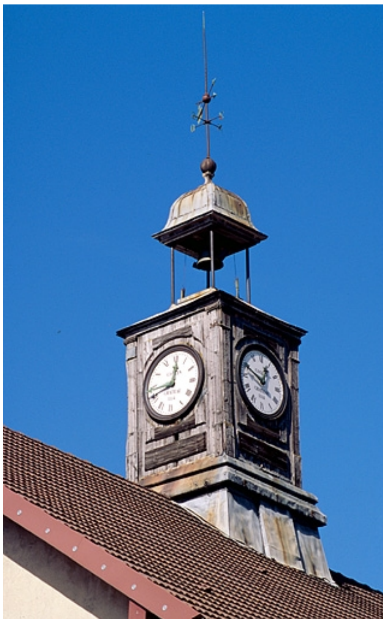
Foncine-le-Haut : clocheton de l'usine d'horlogerie Château.
