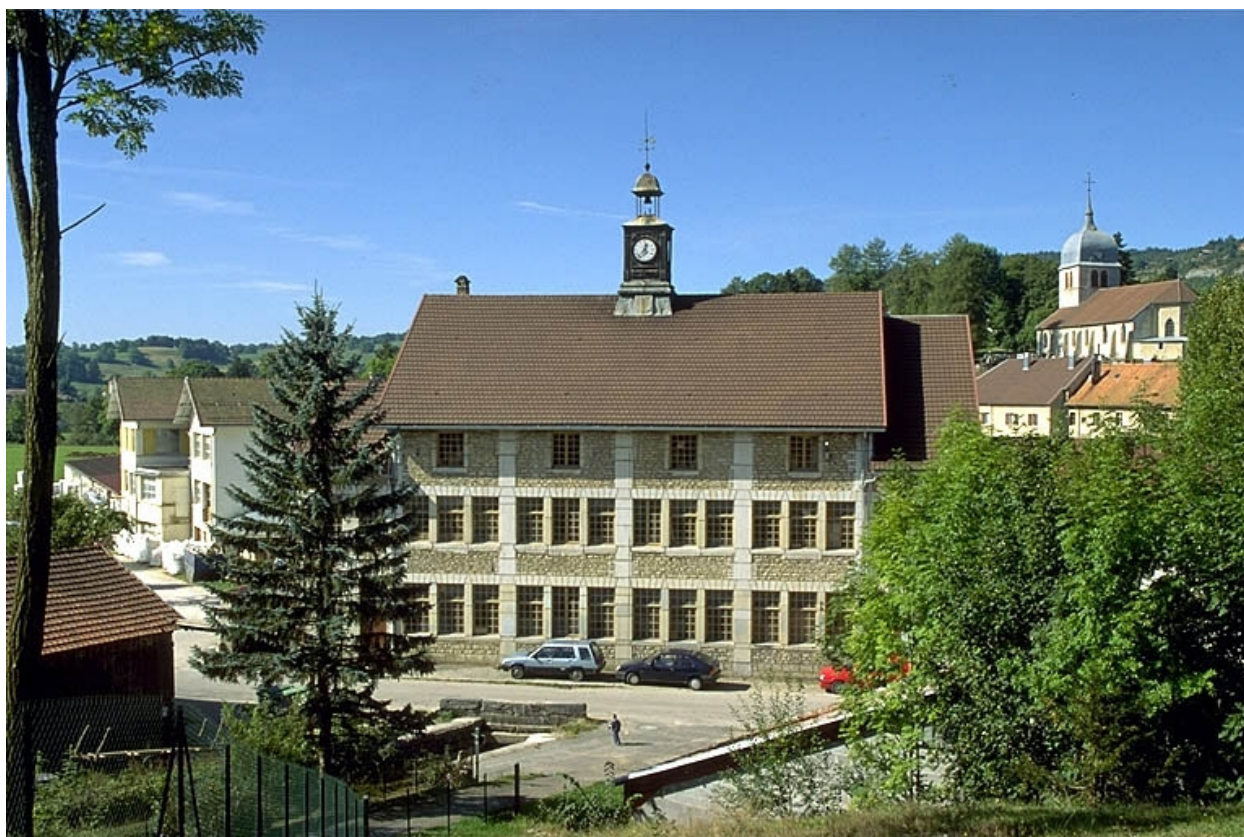
Foncine-le-Haut : usine d'horlogerie Château.
